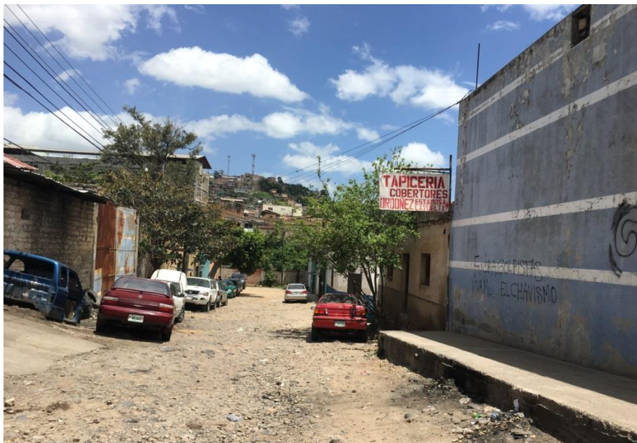
FINAL DEL TRAMO NO. 1
