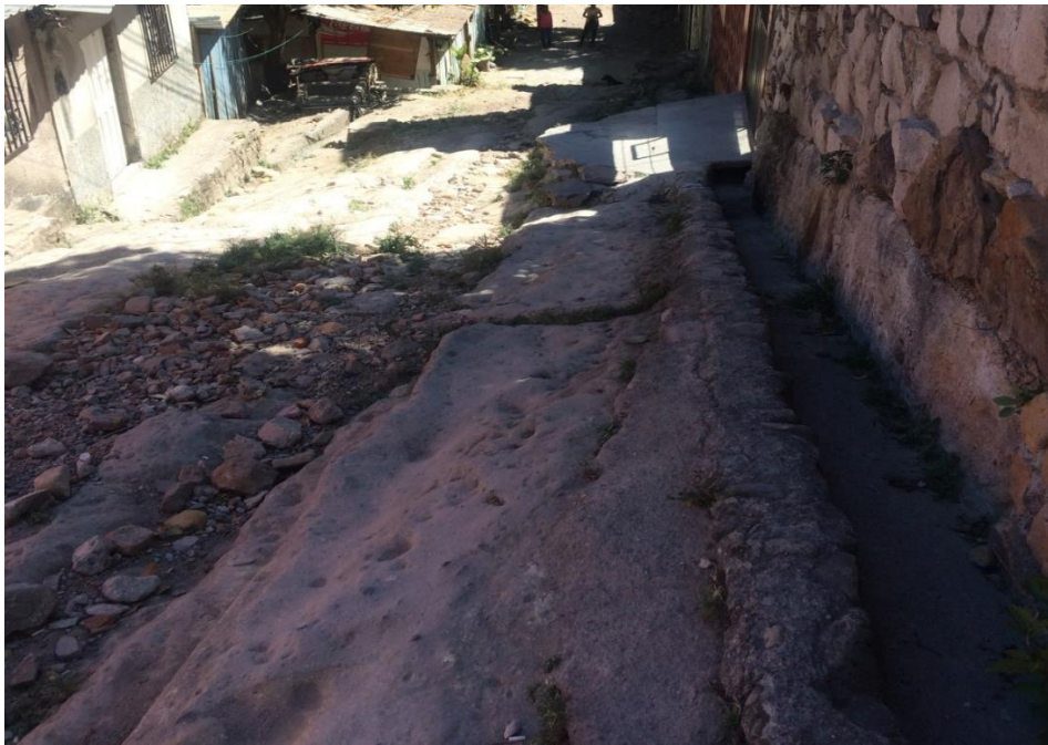
TRAMO A PAVIMENTAR
