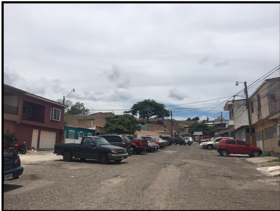
Foto No. 2: Estado actual de la calle "A"
