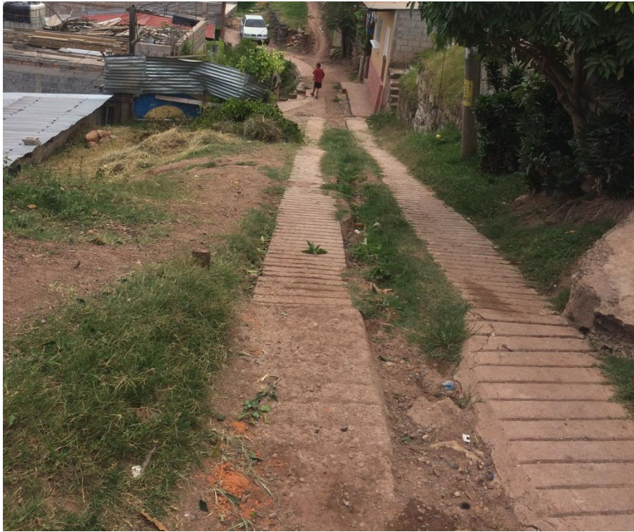
Panorama de calle en la que se demolerán elementos de concreto
