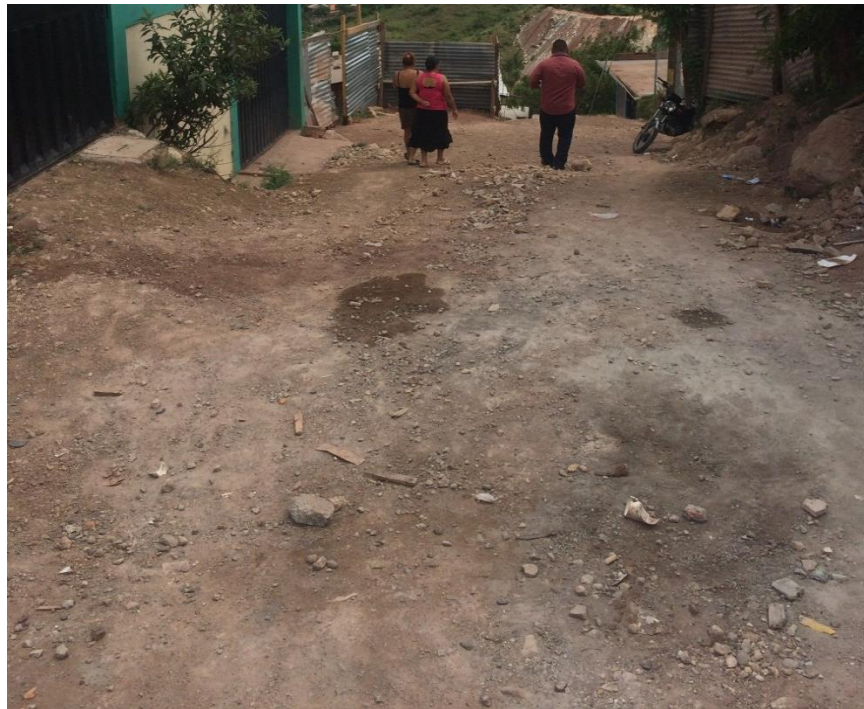
Inicio de calle a pavimentar con concreto hidráulico
