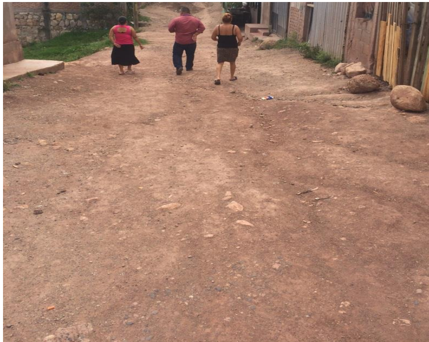
Panorama de calle a pavimentar con concreto hidráulico
