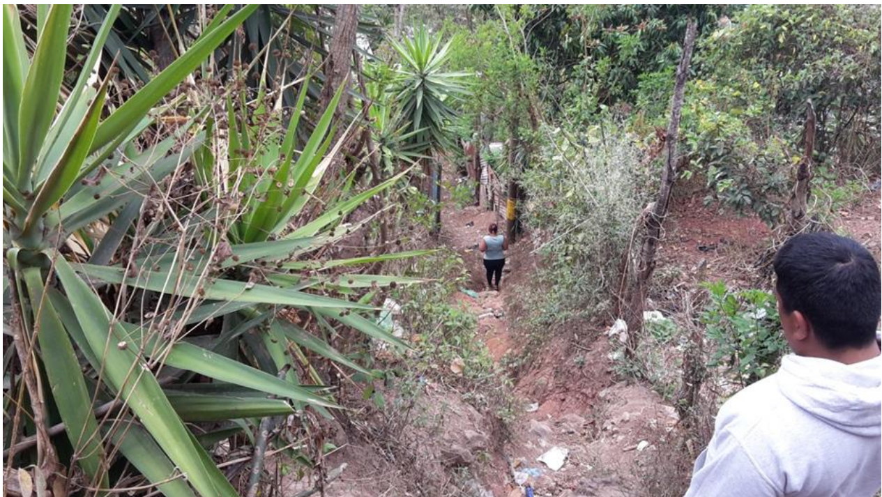
FINAL DE CONSTRUCCIÓN DE GRADAS Y CUNETAS
