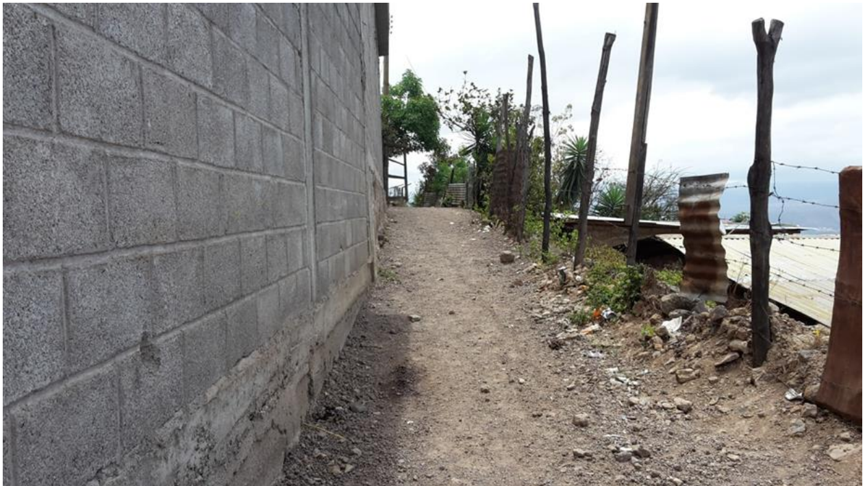
COMIENZO DE LA ACERA A CONSTRUIR
