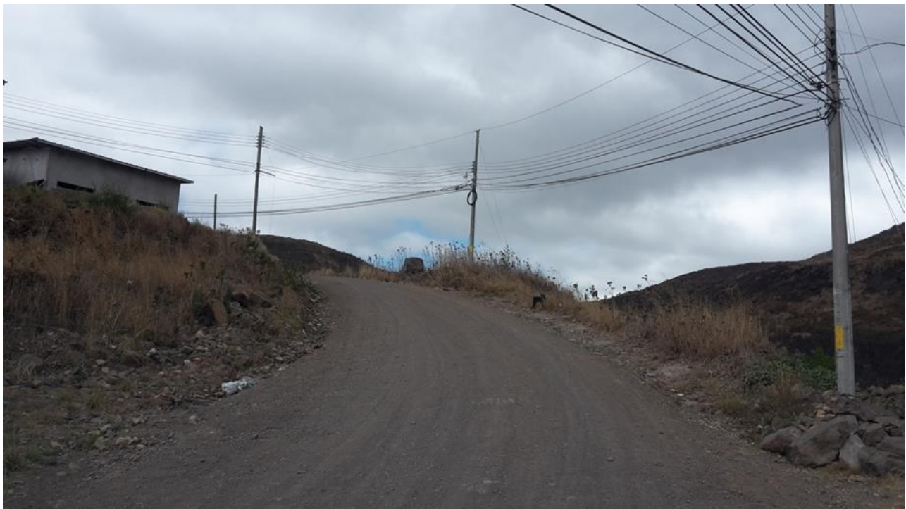
VISTA DE LA CALLE EN QUE SE EJECUTARÁ PARTE DE LA OBRA
