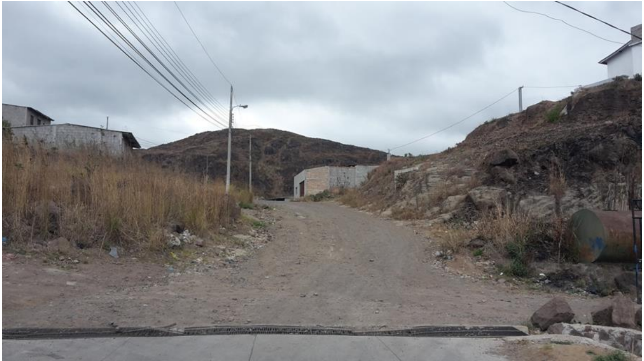
INICIO DE CALLE EN QUE SE CONSTRUIRÁN HUELLAS VEHICULARES
