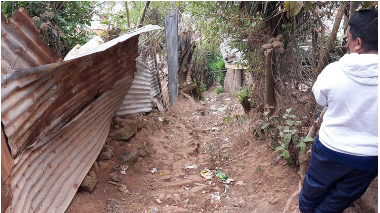
INICIO DE CONSTRUCCIÓN DE GRADAS PEATONALES Y CUNETAS
