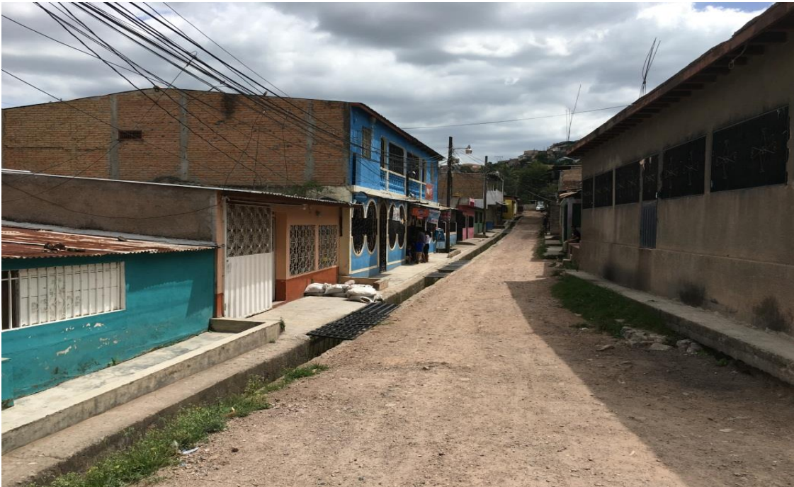
Panorama del tramo a pavimentar con concreto hidráulico
