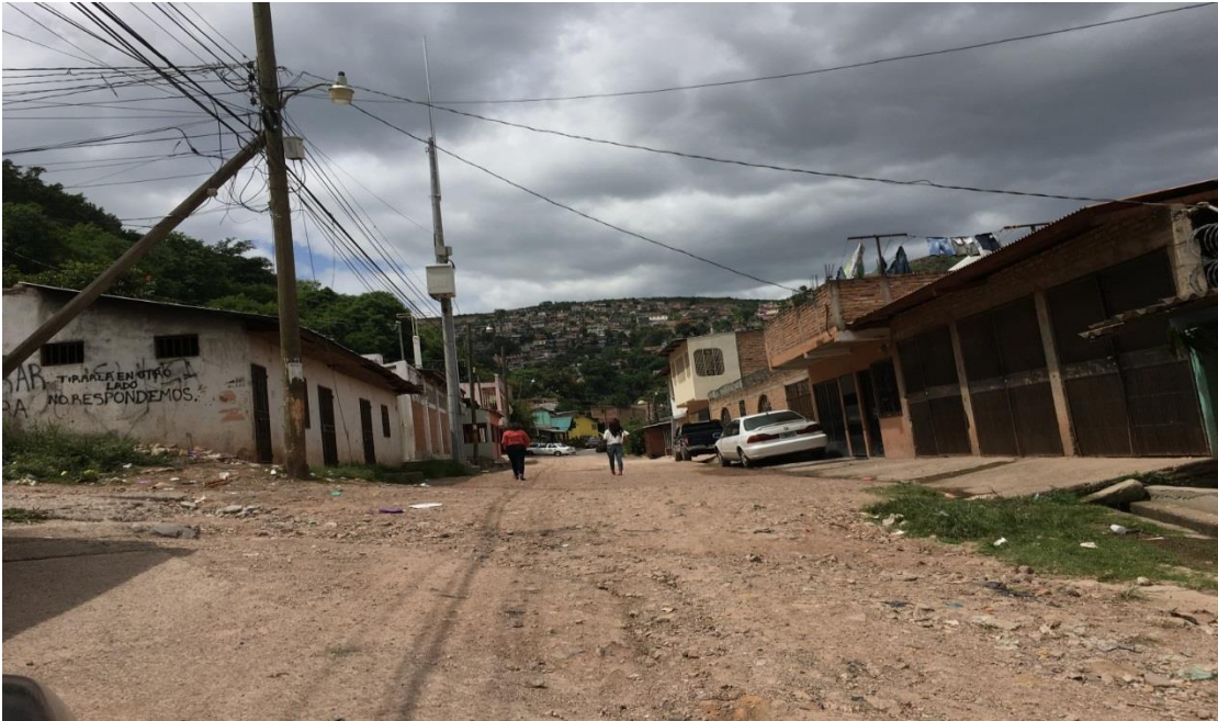
Panorama del tramo a pavimentar con concreto hidráulico y sección en donde se construirán las cunetas
