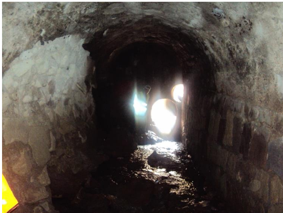
Vista dentro del embaulado existente
