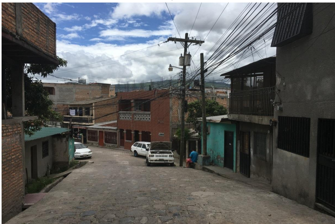
pavimentar con white topping
