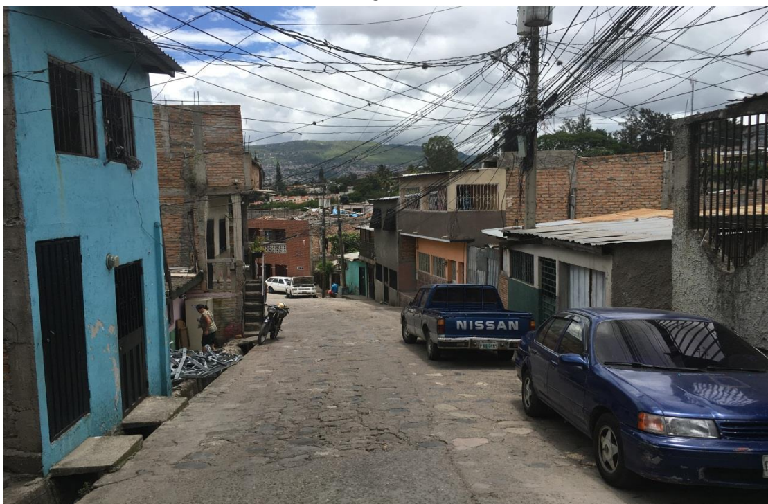
Panorama del tramo a pavimentar con White Topping Calle empedrada
