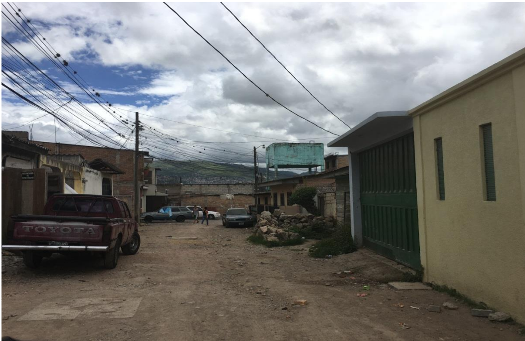
Inicio de tramo a pavimentar con concreto hidráulico
