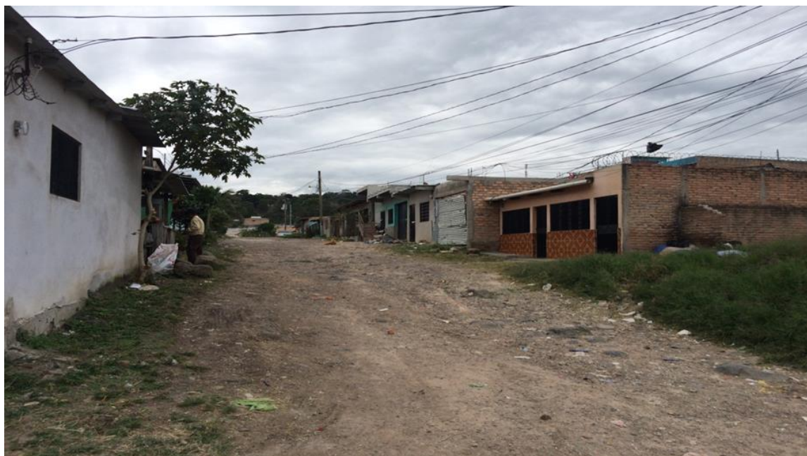
Panorama del mal estado de la calle a pavimentar con concreto hidráulico
