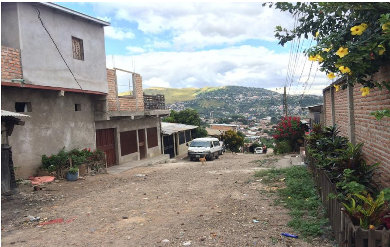
Panorama de calle a pavimentar con concreto hidráulico
