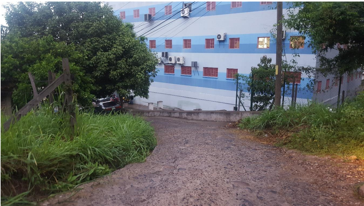
Final del tramo a pavimentar con concreto hidráulico
