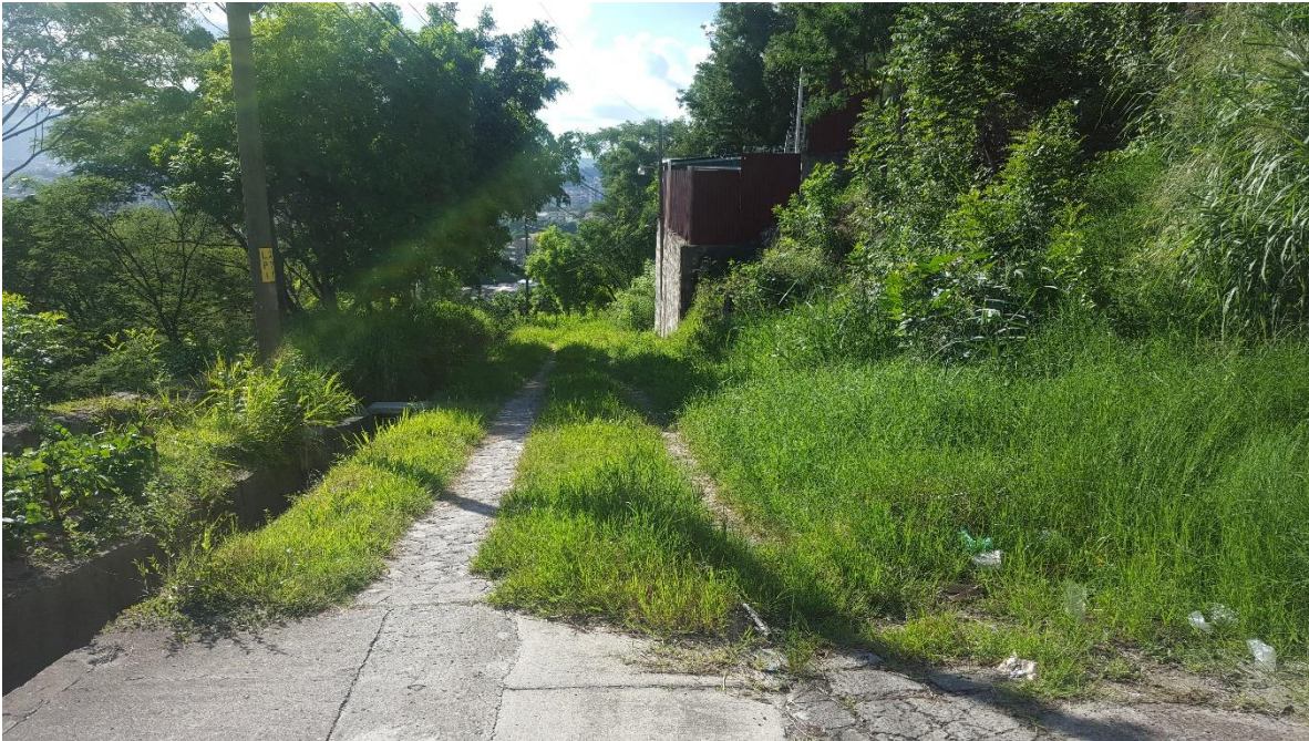
Inicio de tramo a pavimentar con concreto hidráulico
