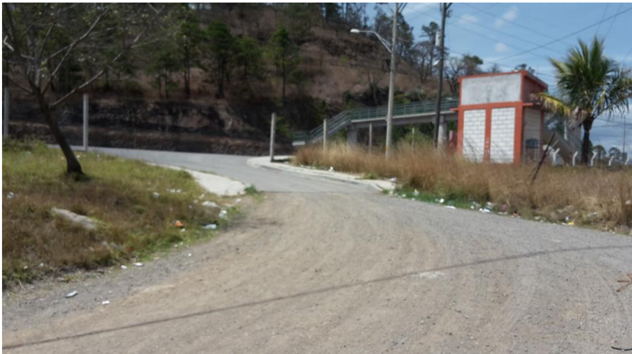
FINAL DE PAVIMENTACIÓN EN TRAMO 1, SE CONECTARÁ A PAVIMENTO EXISTENTE DE LA CARRETERA CA-5
