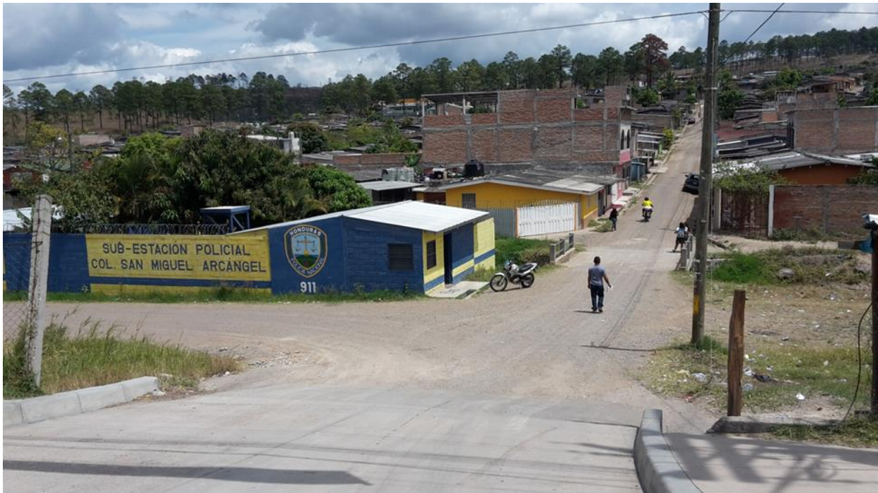
INICIO DE PAVIMENTACIÓN EN TRAMO 1, SE CONECTARÁ A PAVIMENTO EXISTENTE DE LA CARRETERA CA-5
