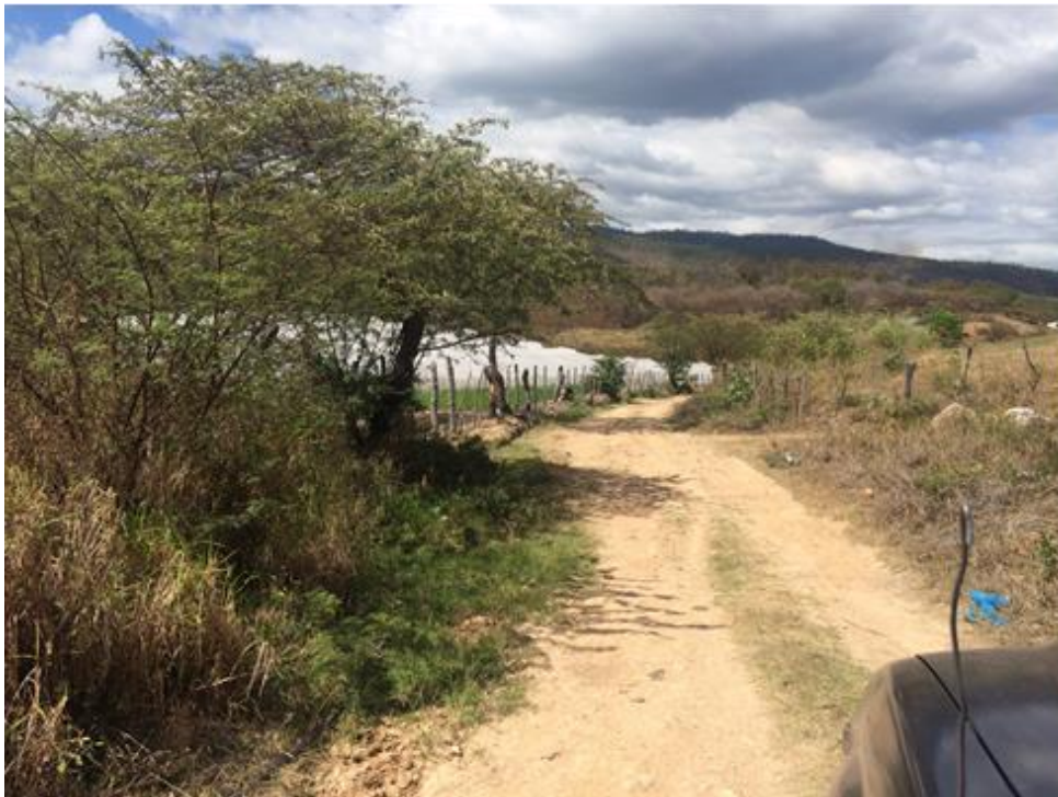
VISTA PANORÁMICA DE CALLE A REPARAR
