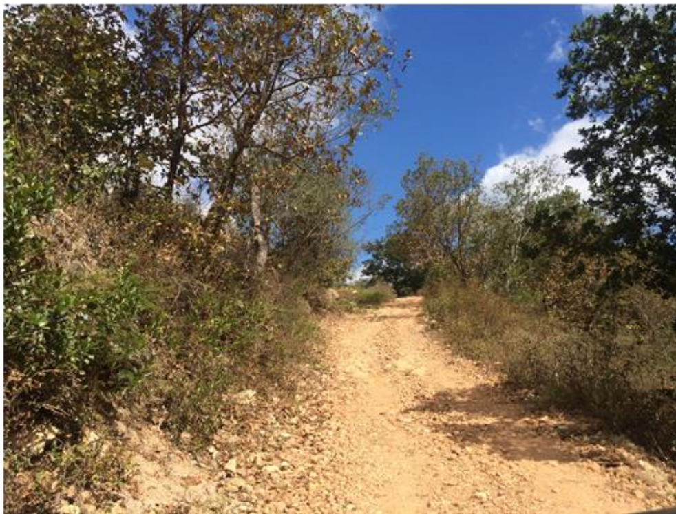
VISTA DE CALLE QUE REQUIERE BALASTADO
