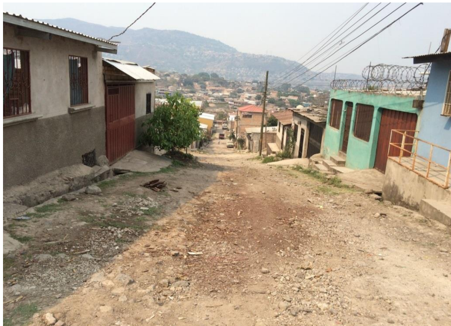
2. VISTA DE ESTADO ACTUAL DE CALLE A PAVIMENTAR
