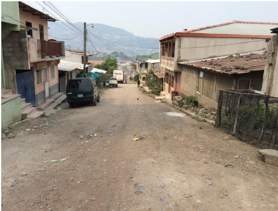
1. VISTA PANORAMICA DE CALLE A PAVIMENTAR
