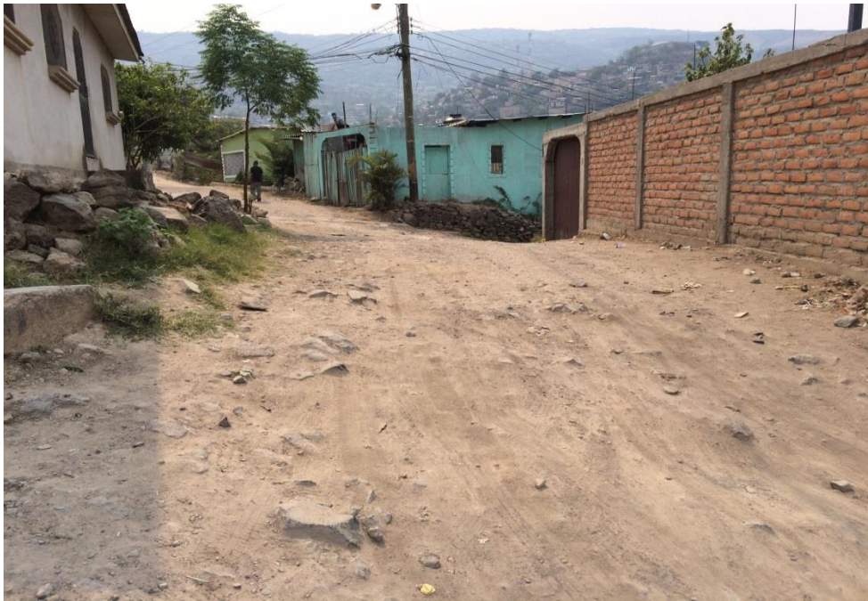
3. VISTA ESTADO ACTUAL DE CALLE A PAVIMENTAR
