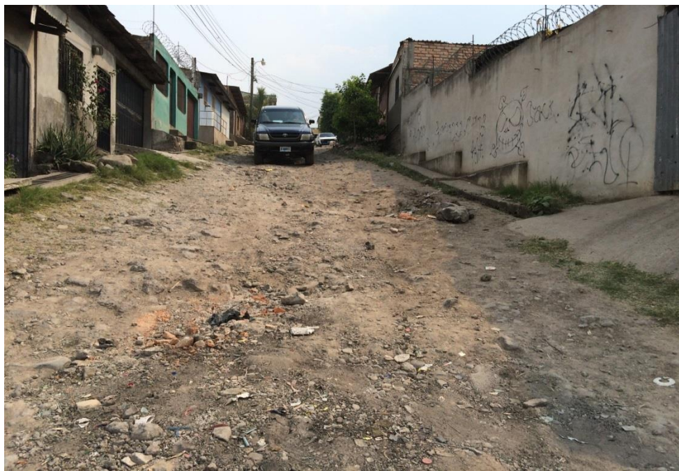
4. VISTA PANORAMICA DE CALLE A PAVIMENTAR
