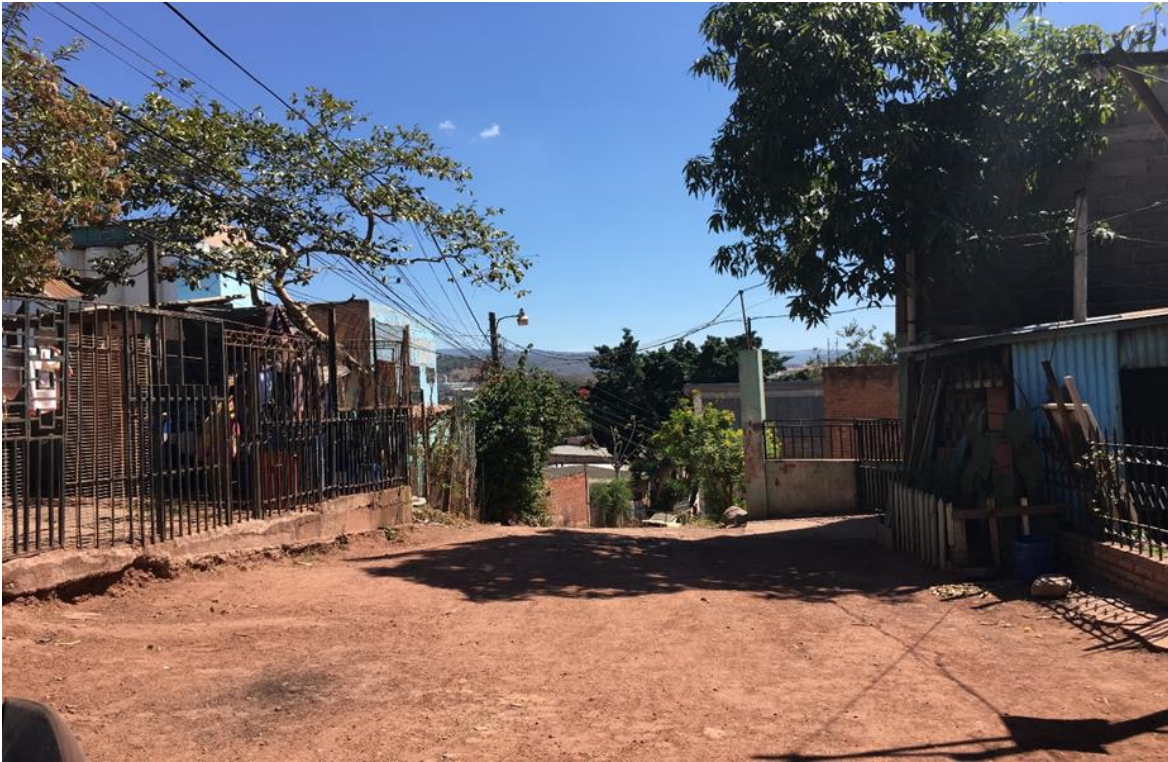
VISTA DE CALLE A PAVIMENTAR CON CONCRETO HIDRAULICO
