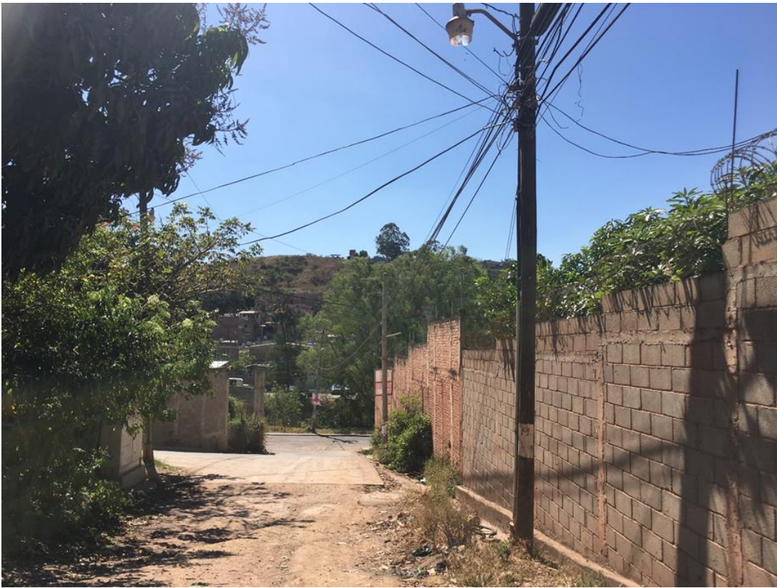
PANORAMA DE LA CALLE QUE REQUIERE PAVIMENTACION
