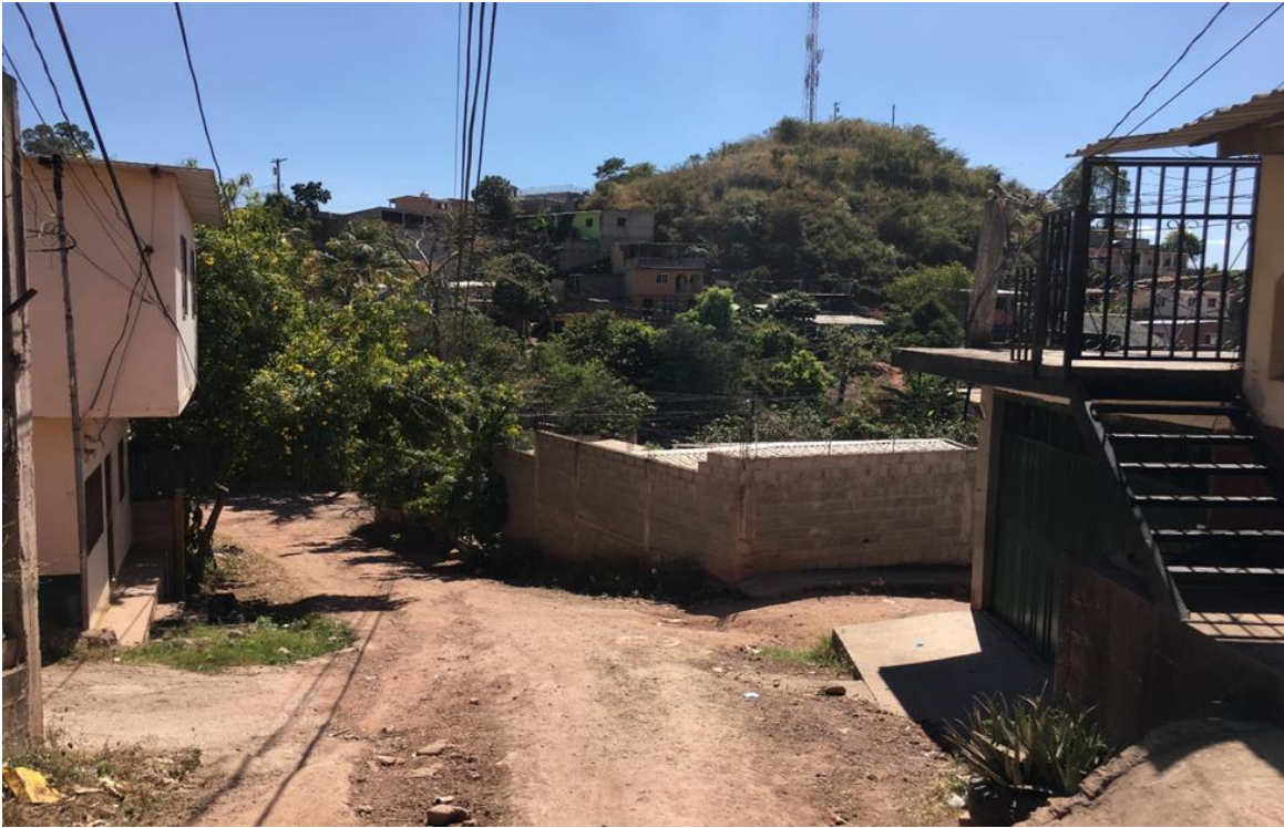
SE OBSERVA EL MAL ESTADO DE LA CALLE
