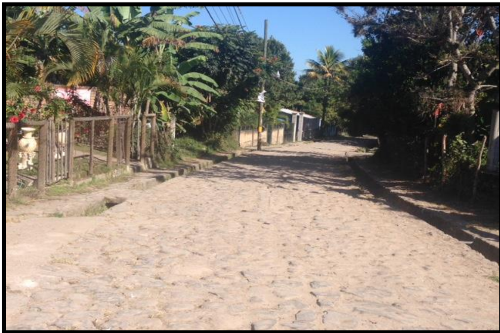
Vista del final del tramo a Rehabilitar
