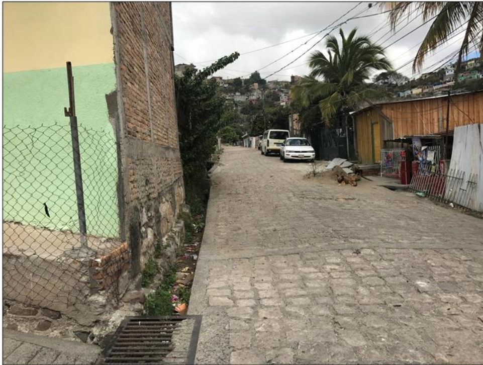
VISTA PANORÁMICA HACIA EL SUR TRAMO 2, PAVIMENTACIÓN CON WHITE TOPPING
