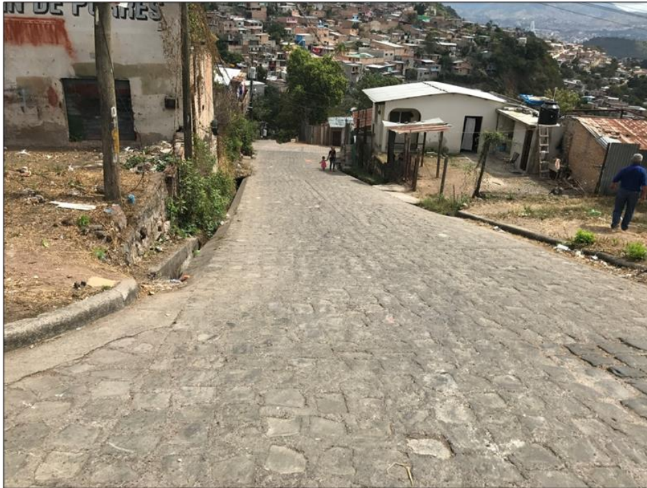
INICIO TRAMO 1, PAVIMENTACIÓN CON WHITE TOPPING
