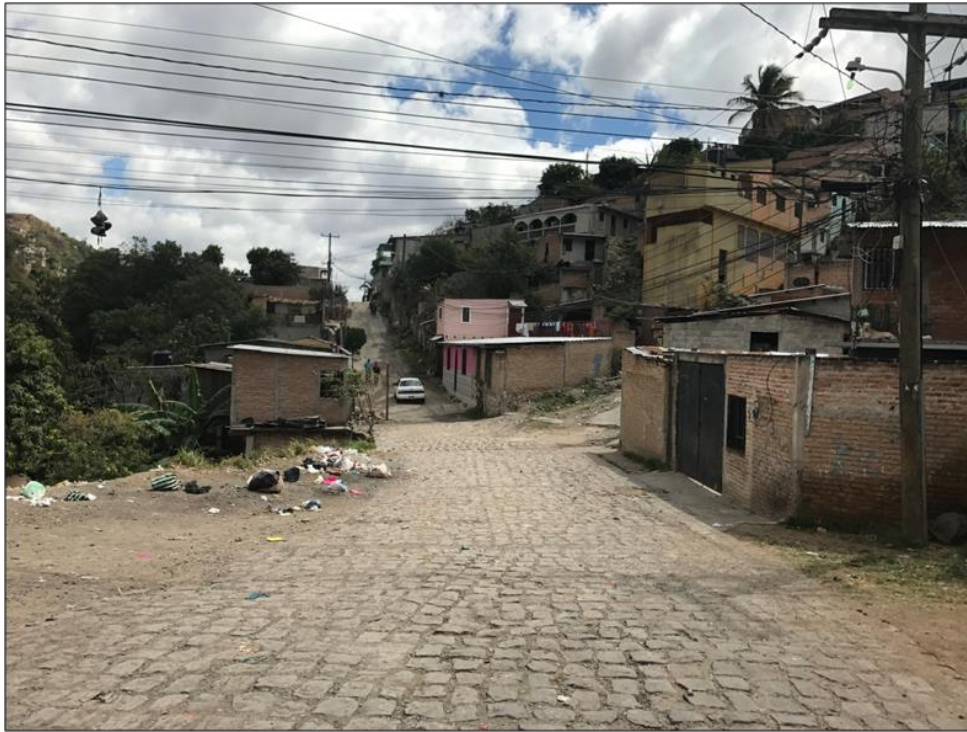
VISTA PANORÁMICA TRAMO 3, PAVIMENTACIÓN CON WHITE TOPPING
