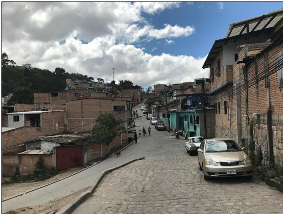
VISTA PANORÁMICA TRAMO 2, PAVIMENTACIÓN CON WHITE TOPPING
