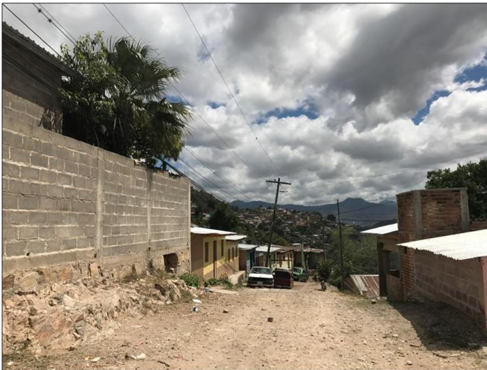
VISTA PANORÁMICA TRAMO 4, PAVIMENTACIÓN CON CONCRETO HIDRÁULICO
