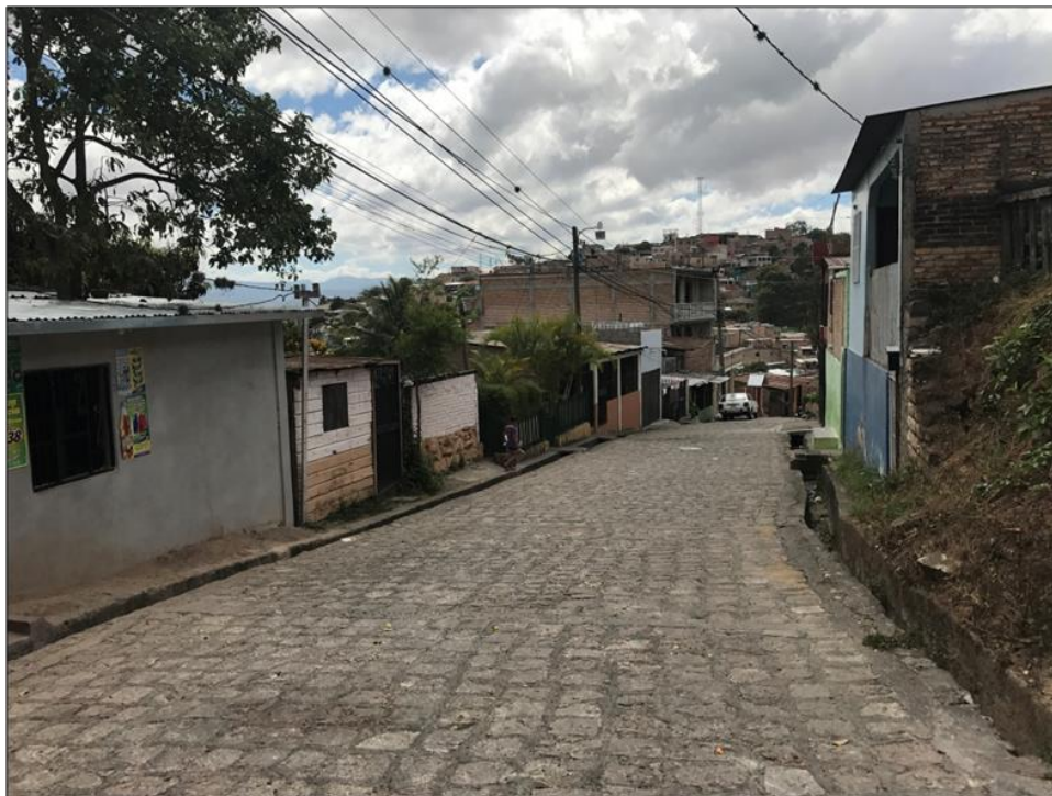
VISTA PANORÁMICA HACIA EL NORTE TRAMO 2, PAVIMENTACIÓN CON WHITE TOPPING
