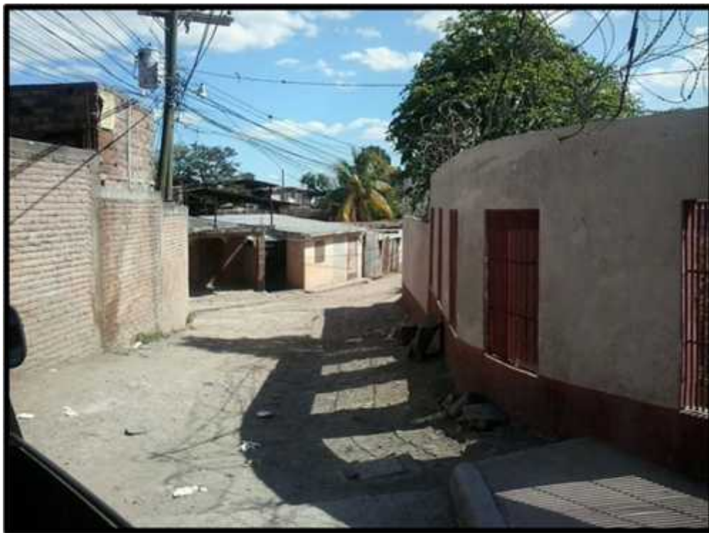
Vista del mal estado de la calle en Col. Continental
