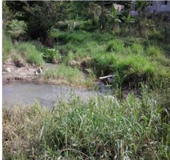
Panorama de sitio en donde se construirá el vado inundable en aldea Las Casitas
