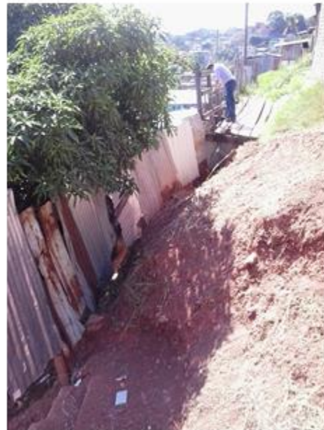
Panorama donde se construirá el muro de contención en la colonia 3 De Mayo.
