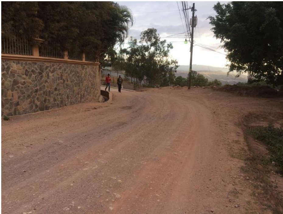
INICIO DE LA OBRA A EJECUTAR
