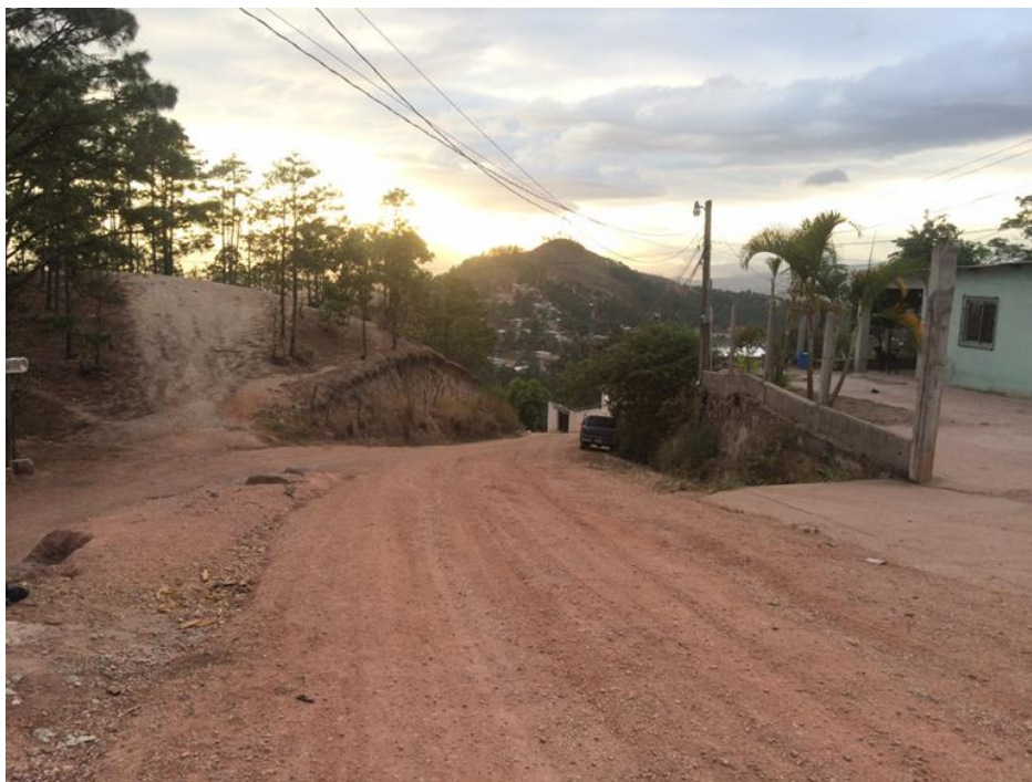
CALLE EN QUE SE EJECUTARÁ LA OBRA
