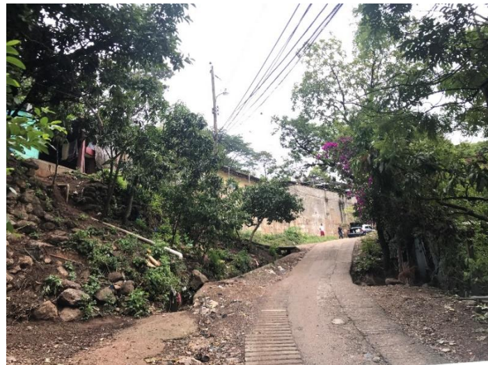
No.2 VISTA DE CALLE DONDE SE CONTRUIRAN HUELLAS VEHICULARES Y MURO A
