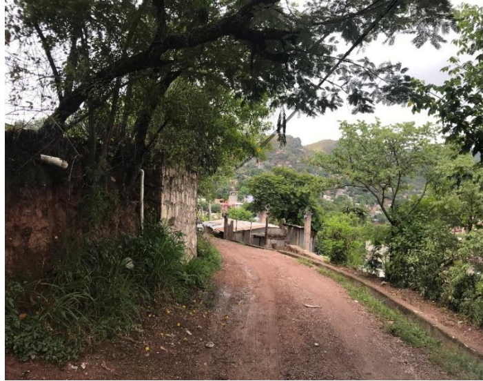
No. 1 VISTA DE CALLE DONDE SE CONTRUIRAN HUELLAS VEHICULARES
