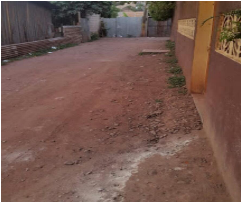
VISTA DEL FINAL DEL TRAMO
