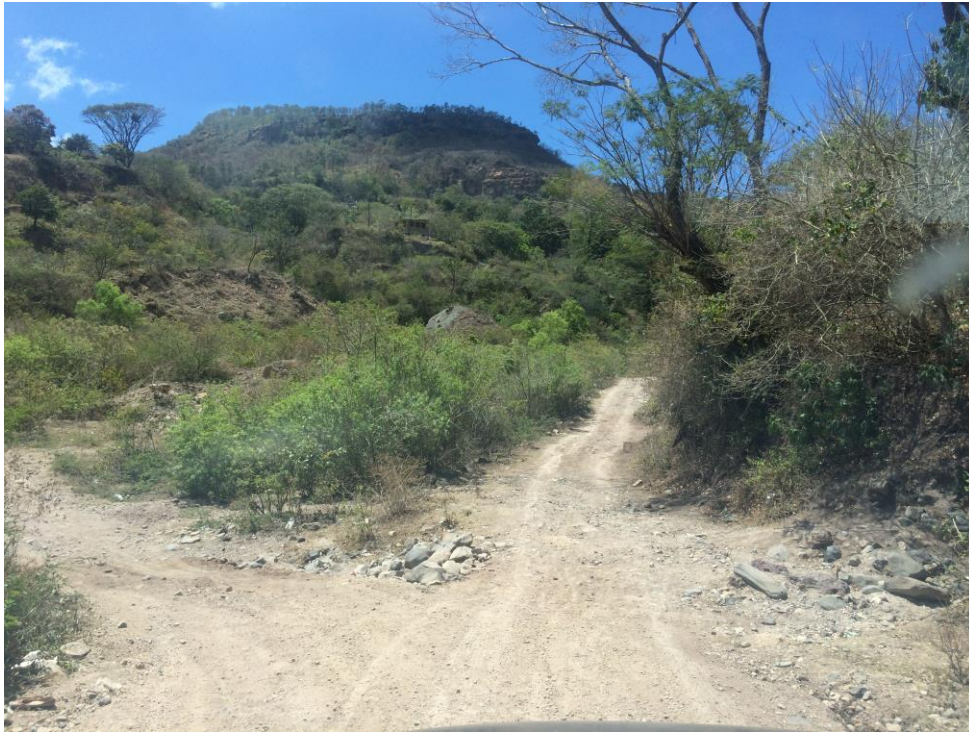
VISTA PANORÁMICA DE CALLE A REPARAR
