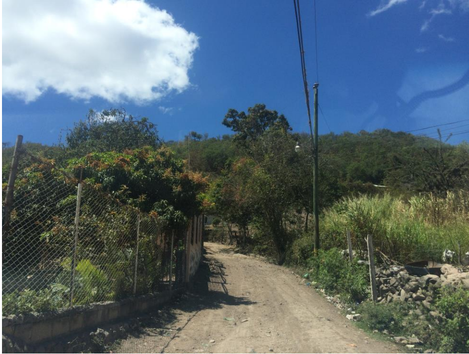
INICIO DE CALLE A REPARAR
