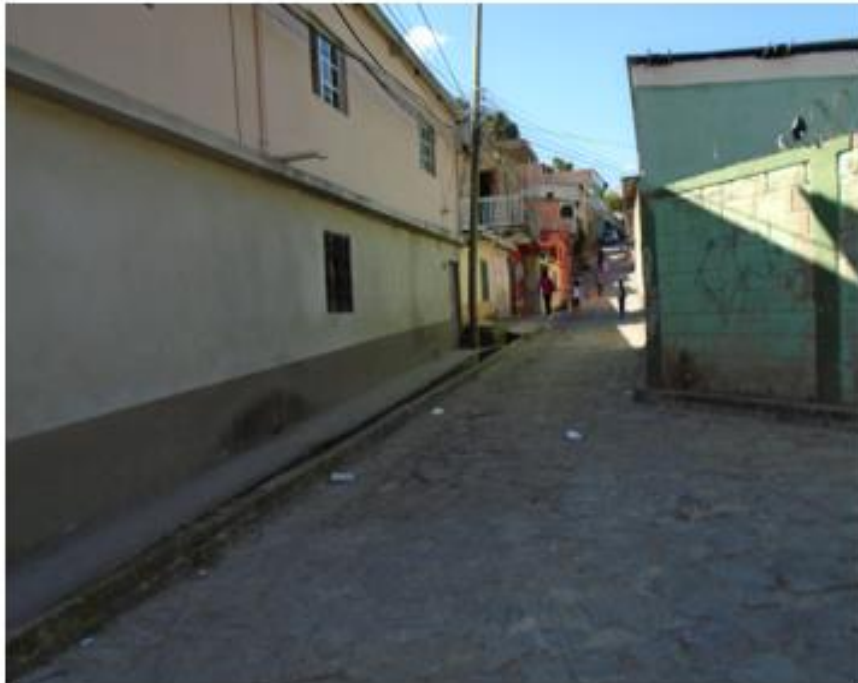
Panorama de tramo donde se construirán bordillos
