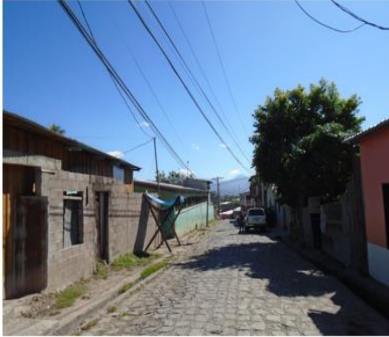
Vista de tramo a pavimentar con white topping
