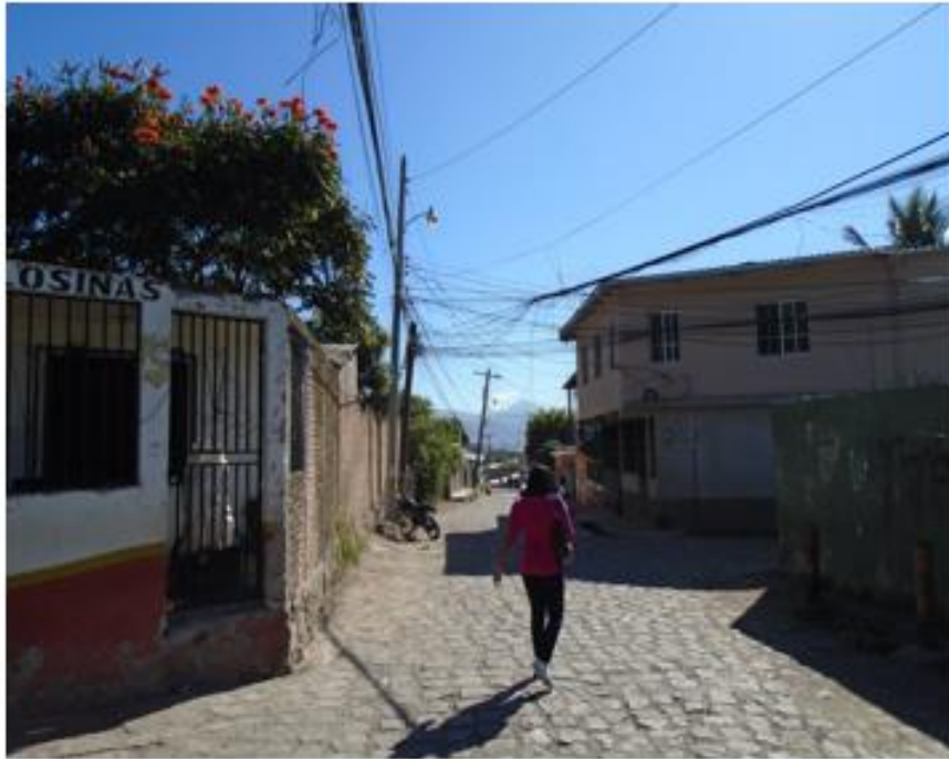
Inicio de tramo a pavimentar con White Topping
