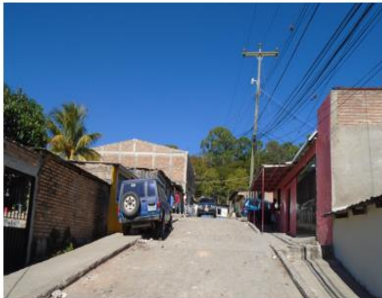
Final de tramo a pavimentar con white topping
