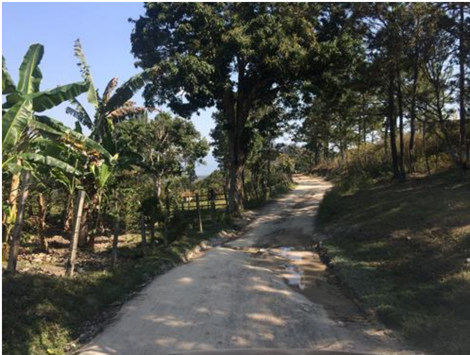
VISTA DE CALLE QUE REQUIERE BALASTADO
