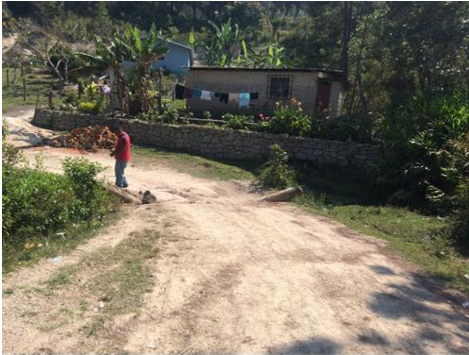
VISTA PANORÁMICA DE CALLE A REPARAR
