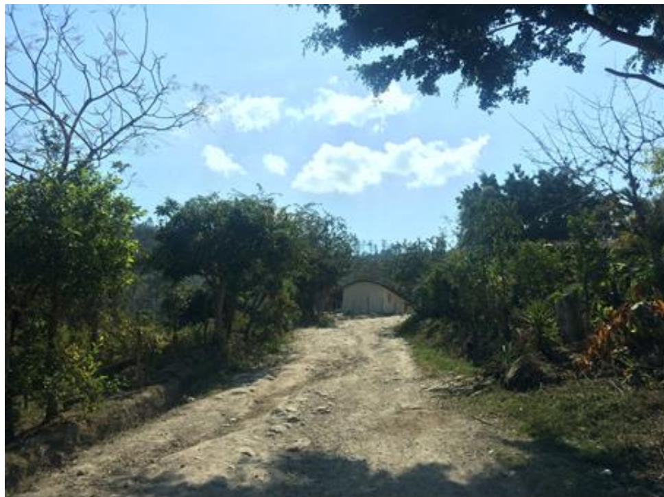
VISTA ACTUAL DE CALLE A REPARAR Y DONDE SE CONSTRUIRÁN LAS HUELLAS
