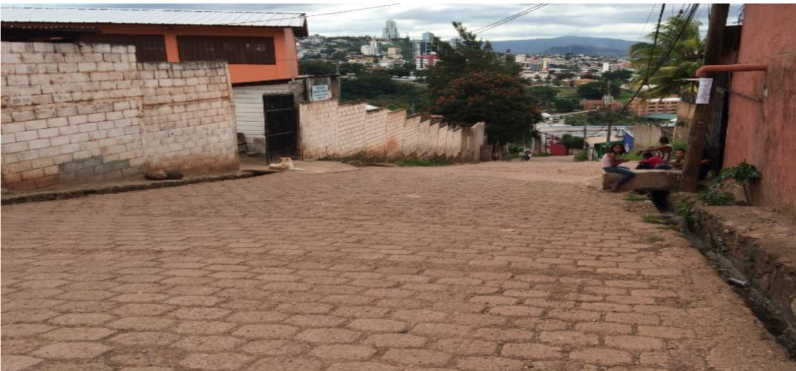
Foto 4: vista del tramo B, de calle a pavimentar
