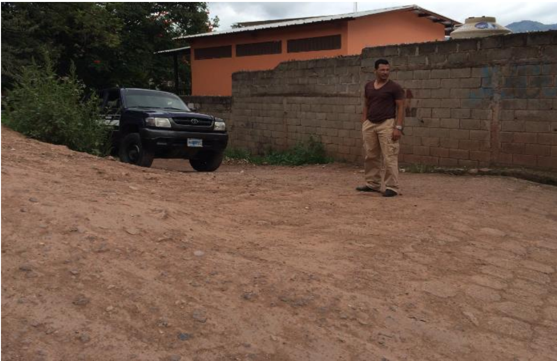
Foto 3: vista de la condicion presente de calle en la cual se hara la pavimentacion con concreto hidraulico.
