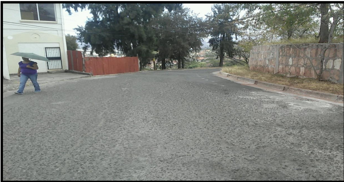
Vista del tramo a trabajar con mezcla Asfáltica
