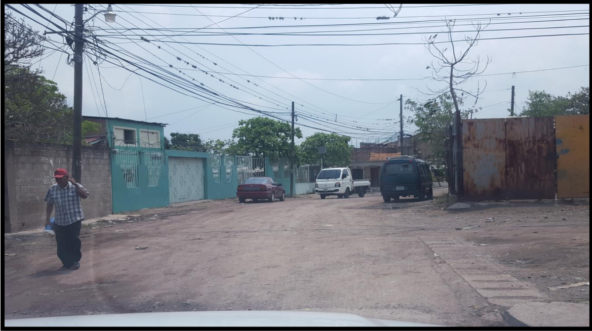
VISTA DEL INICIO DEL TRAMO A PAVIMENTAR
