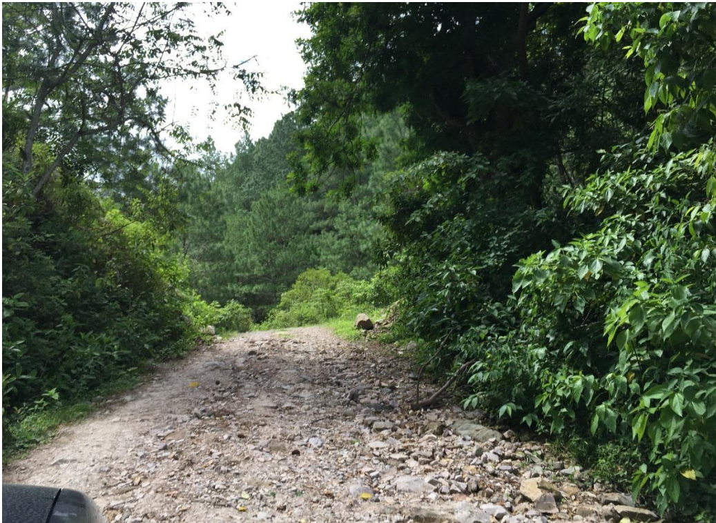
Panorama del tramo en el que se hará el balastado
