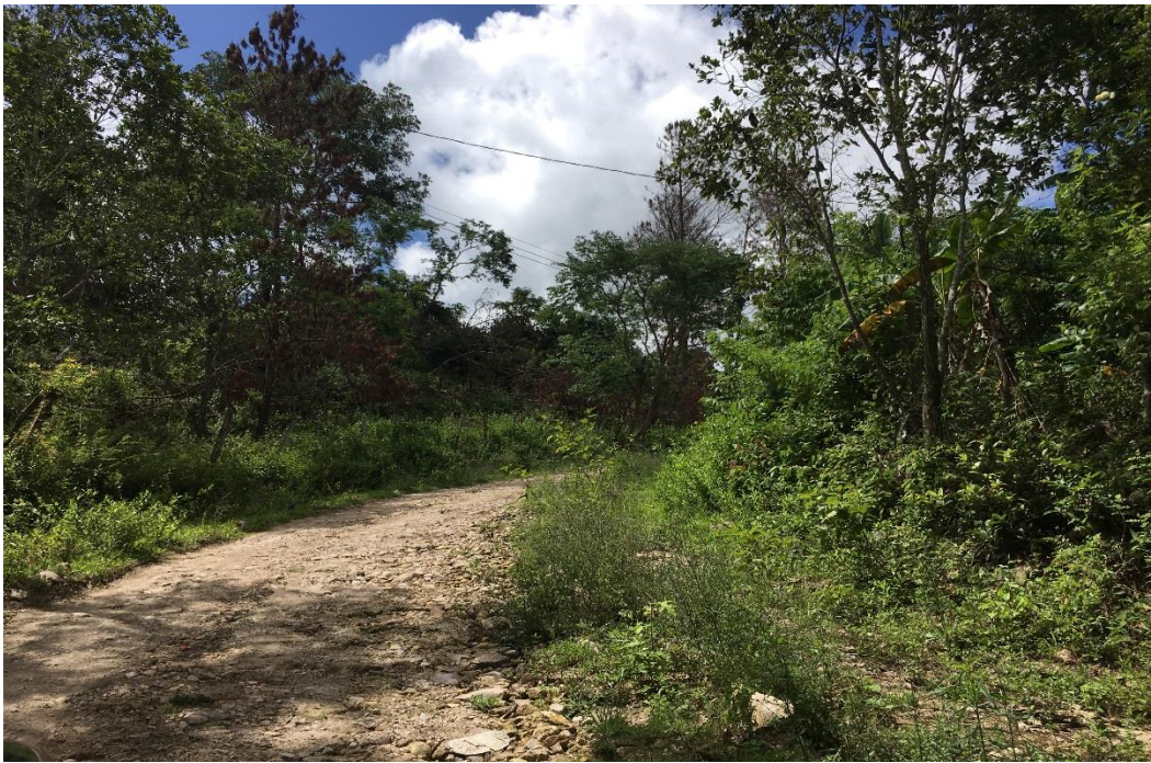
Panorama del tramo en el que se hará el balastado
