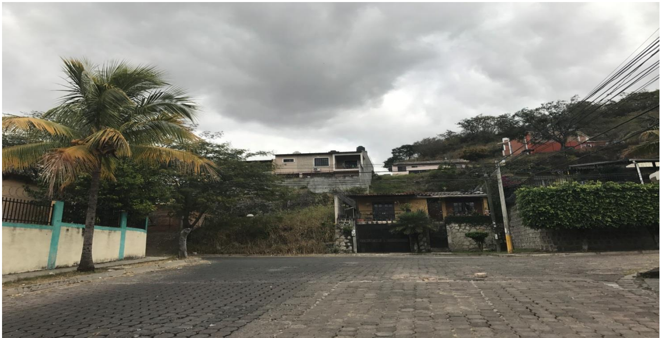
VISTA DE LA CALLE A PAVIMENTAR CON CONCRETO HIDRÁULICO
