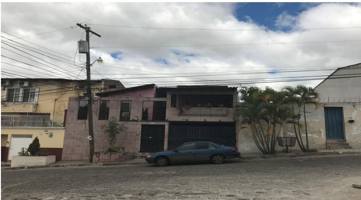
SE OBSERVA EL MAL ESTADO DEL ADOQUINADO
