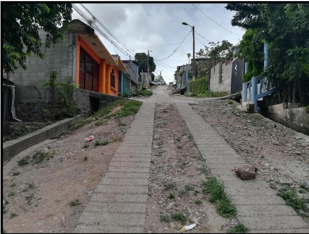
**No.4** Vista de las huellas a demoler en calle 2, longitud de 55 m.
