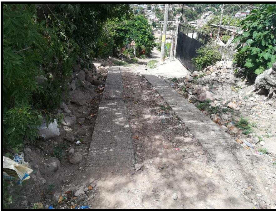
**No.2** Inicio de huellas a demoler en calle 1, longitud total 120 m .
