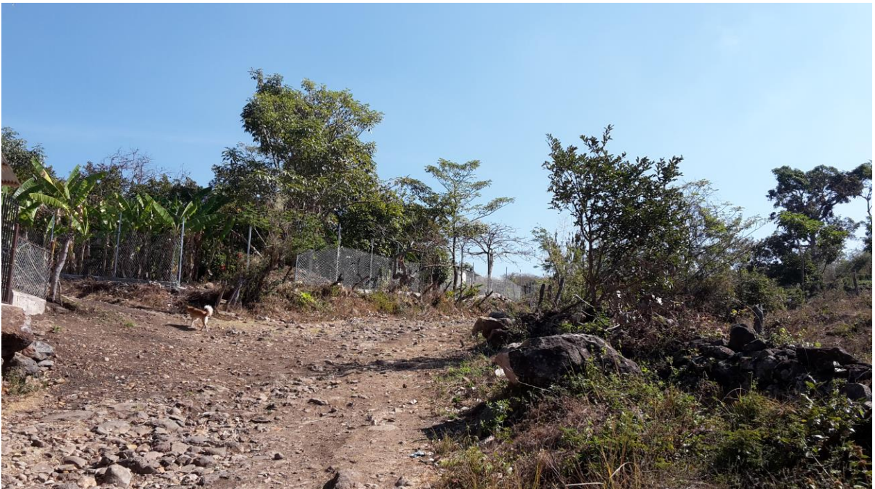
VISTA ACTUAL DE CALLE A REPARAR
