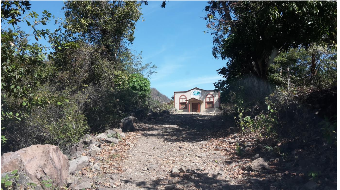
VISTA PANORÁMICA DE CALLE A REPARAR
