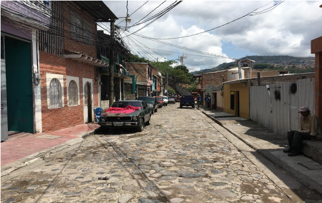
Panorama del tramo a pavimentar con white topping
