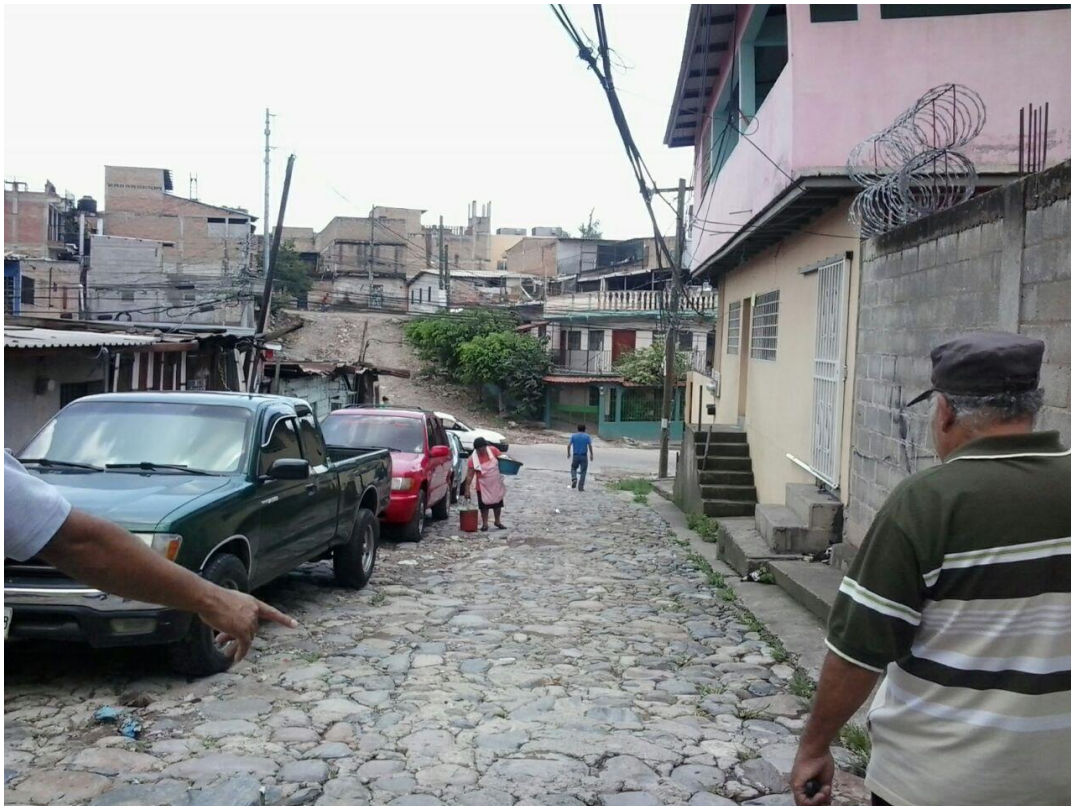
Panorama del tramo a pavimentar con white topping
