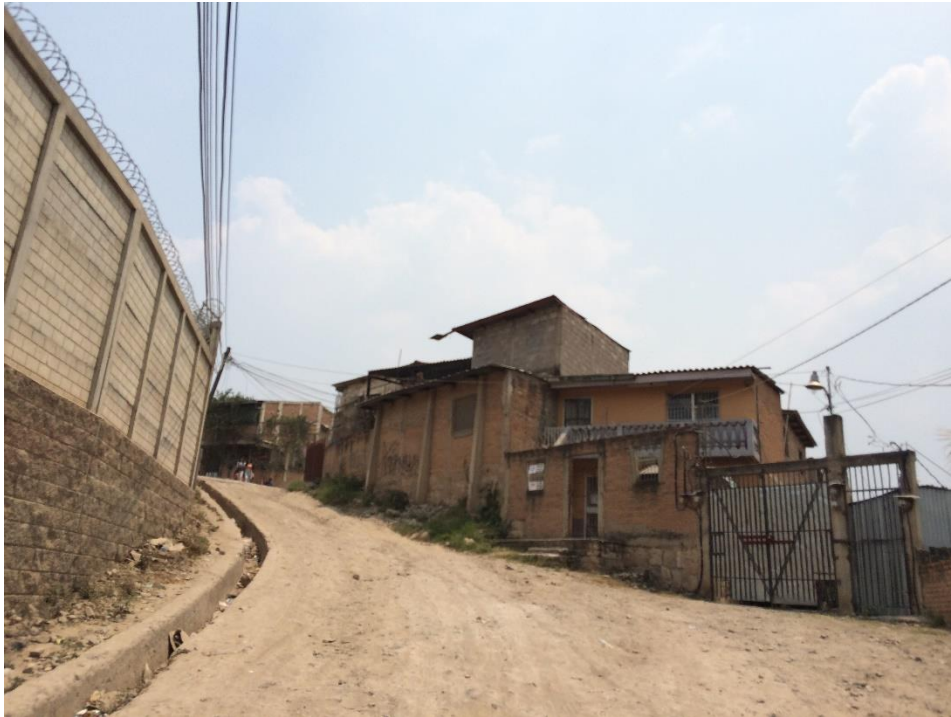
PANORÁMA DE TRAMO A PAVIMENTAR
