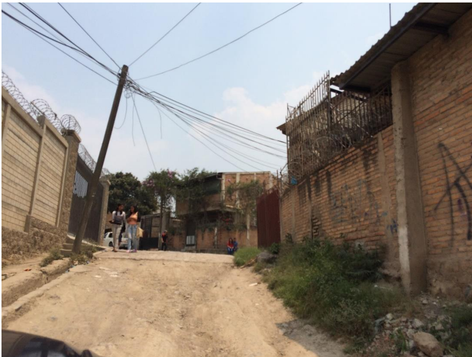
FINAL DE TRAMO A PAVIMENTAR
