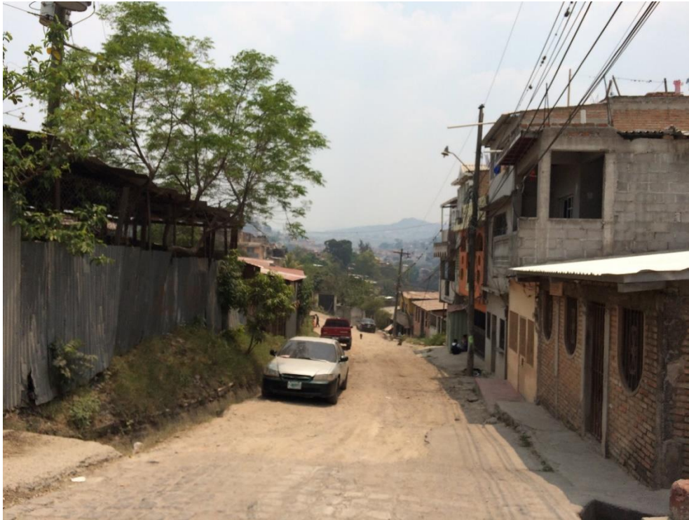
INICIO DE TRAMO A PAVIMENTAR
