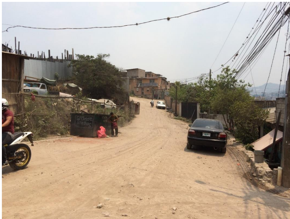
PANORÁMA DE TRAMO A PAVIMENTAR
