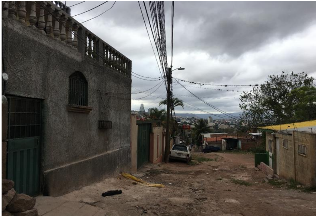
Foto No. 2: tramo a pavimentar
