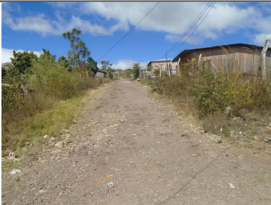
Se observán las malas condiciones de la calle
