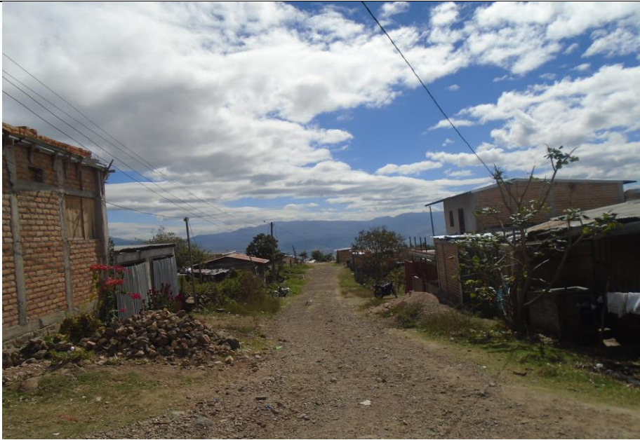
Malas condiciones en que se encuentra una de las calles a intervenir
