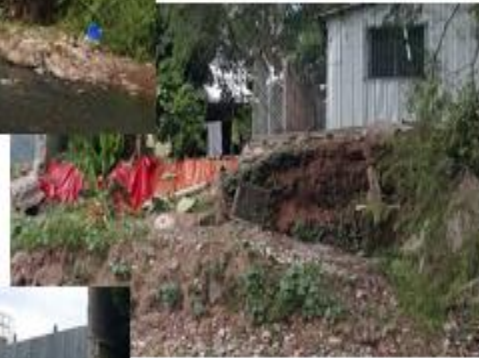
Condiciones actuales donde se construirá Muro de Mampostería Long.: 41 m. H.:5.00 m, Base: 2.50 m.
