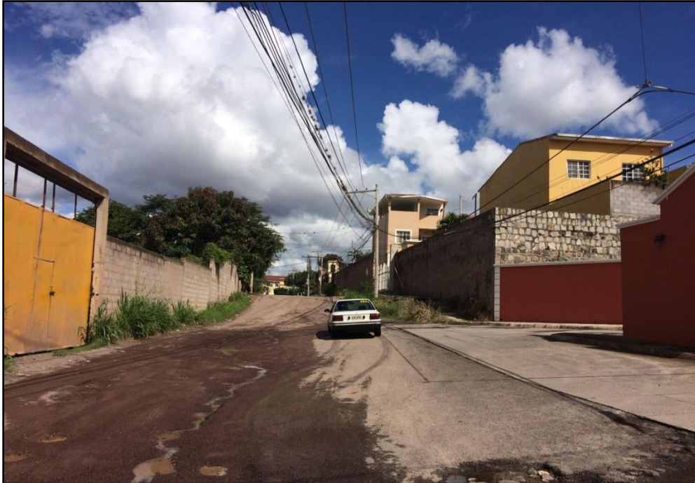
Foto 1. Vista panorámica del tramo a pavimentar
