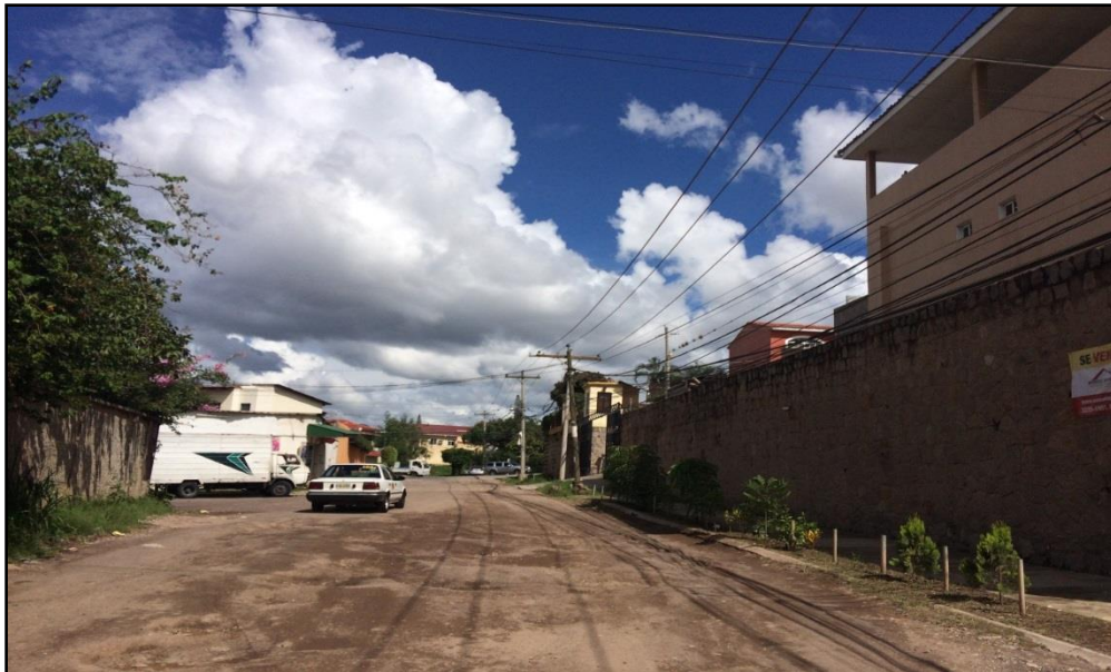
Foto 2. Vista panorámica del tramo a pavimentar
