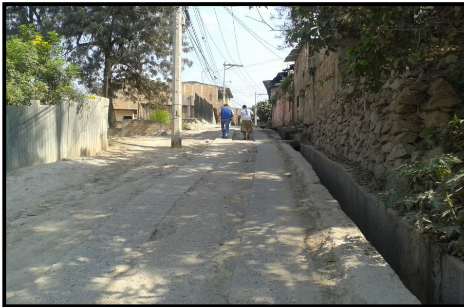
VISTA DEL TRAMO A PAVIMENTAR
