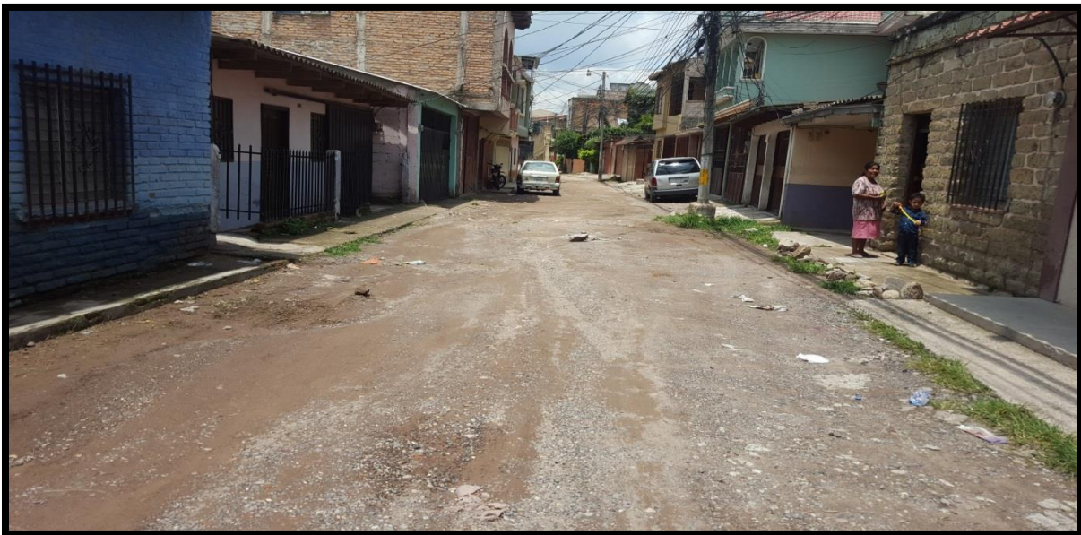
Vista panorámica del tramo a pavimentar
