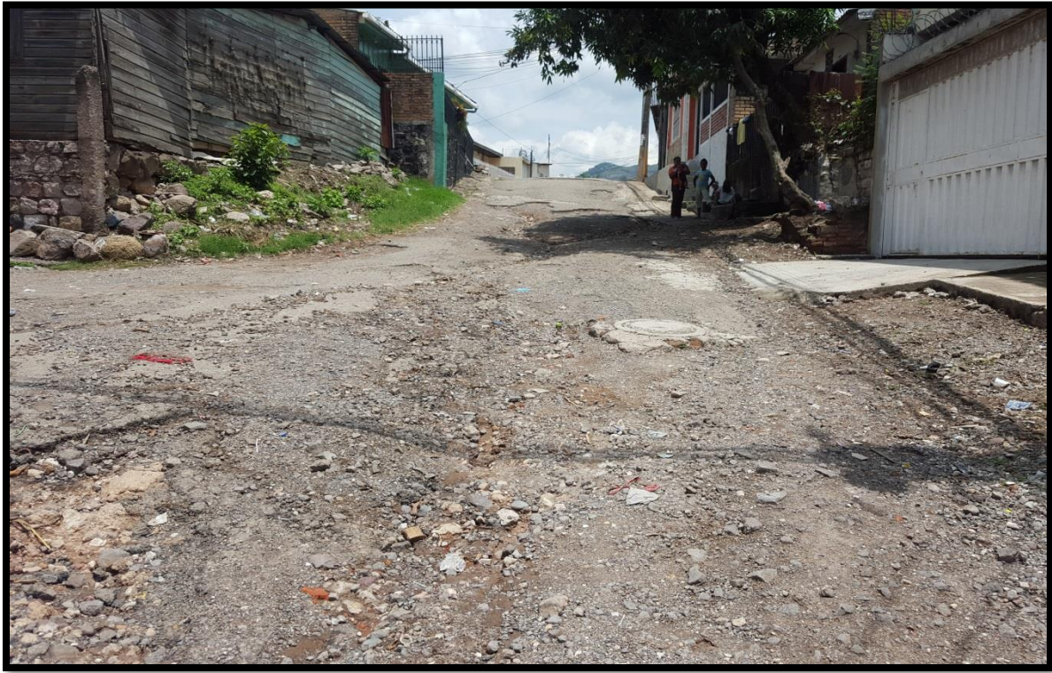
Vista del Tramo con residuos de asfalto y concreto existente
