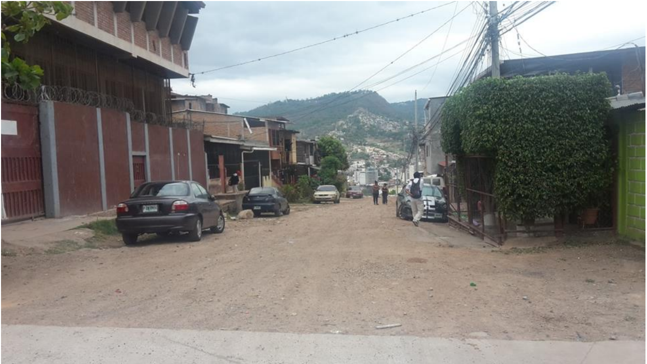
INICIO DEL PROYECTO QUE CONECTARÁ AL PAVIMENTO EXISTENTE
