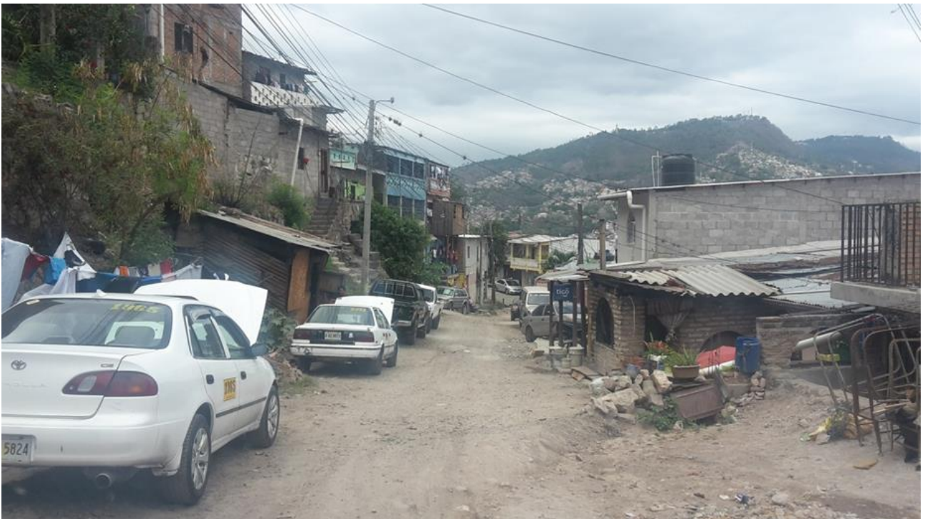
SE OBSERVAN LAS MALAS CONDICIONES DE LA ZONA DONDE FINALIZA EL PROYECTO
