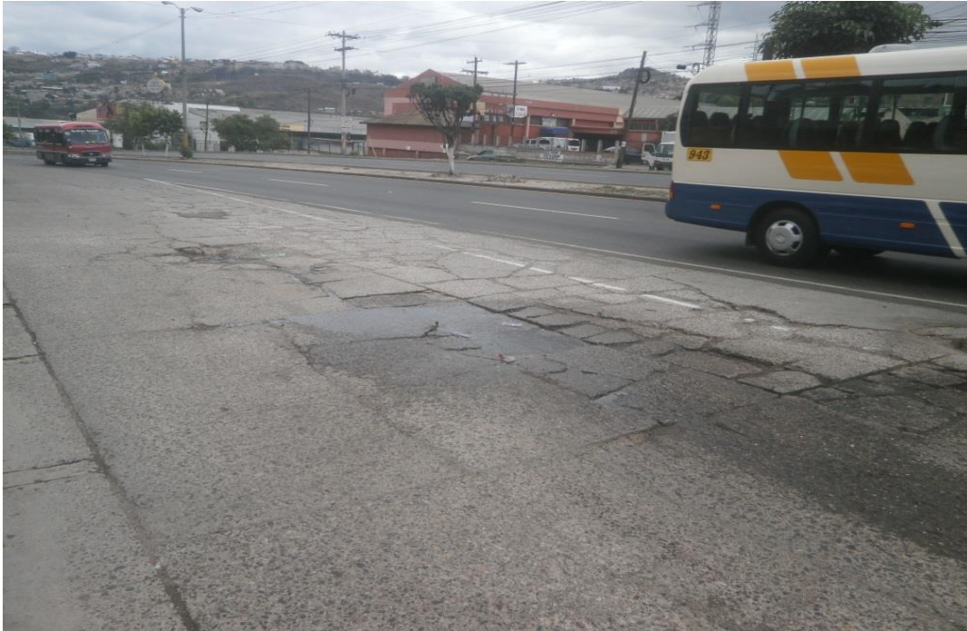
ESTADO ACTUAL ACCESO A RES. CENTROAMERICA ESTE
