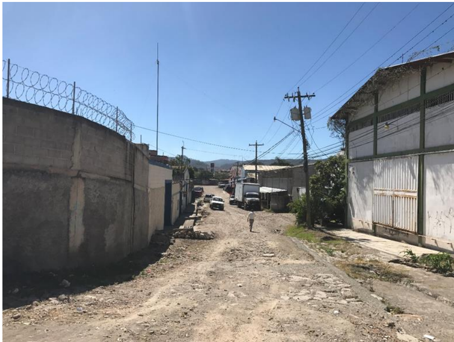
Foto No. 1: Inicio de calle a pavimentar
