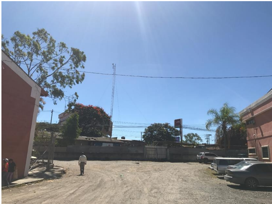
Foto No. 3: Vista de calle a pavimentar
