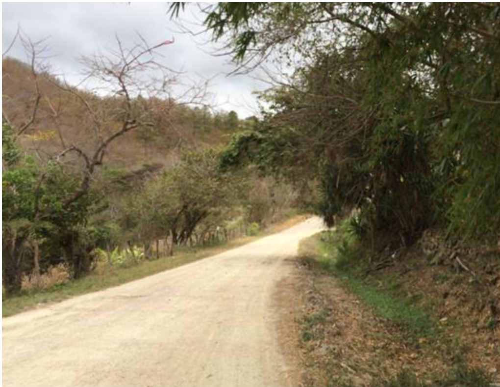
VISTA ACTUAL DE CALLE A REPARAR
