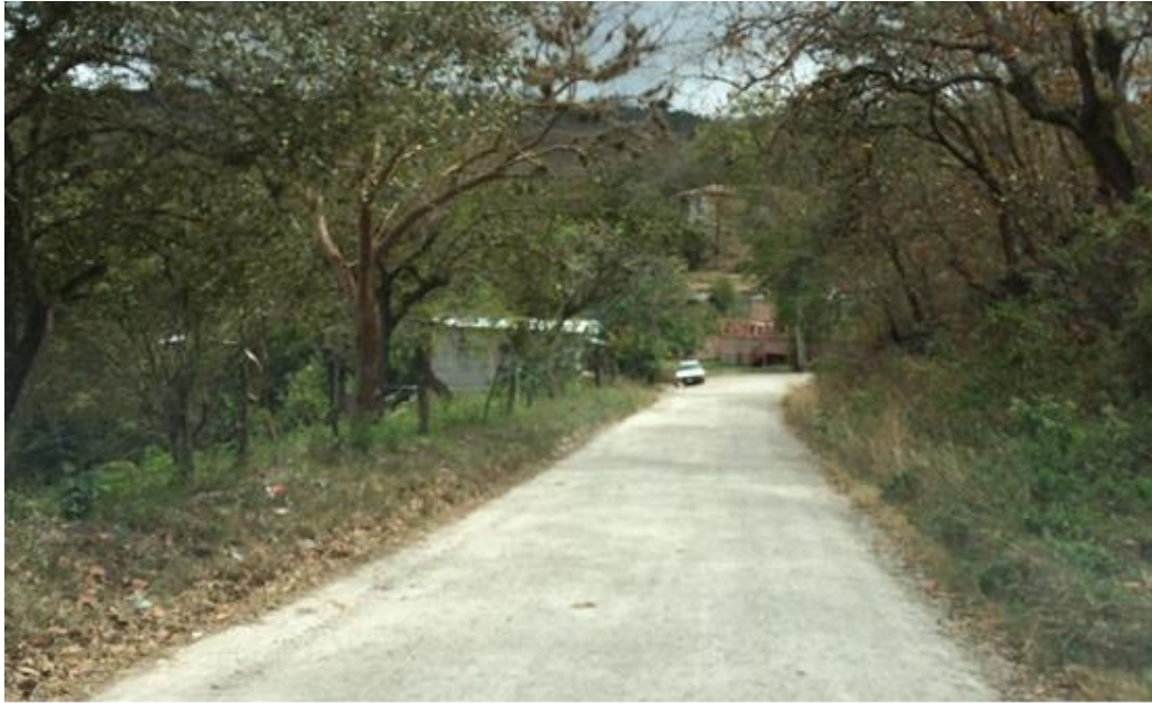
INICIO DE CALLE A REPARAR
