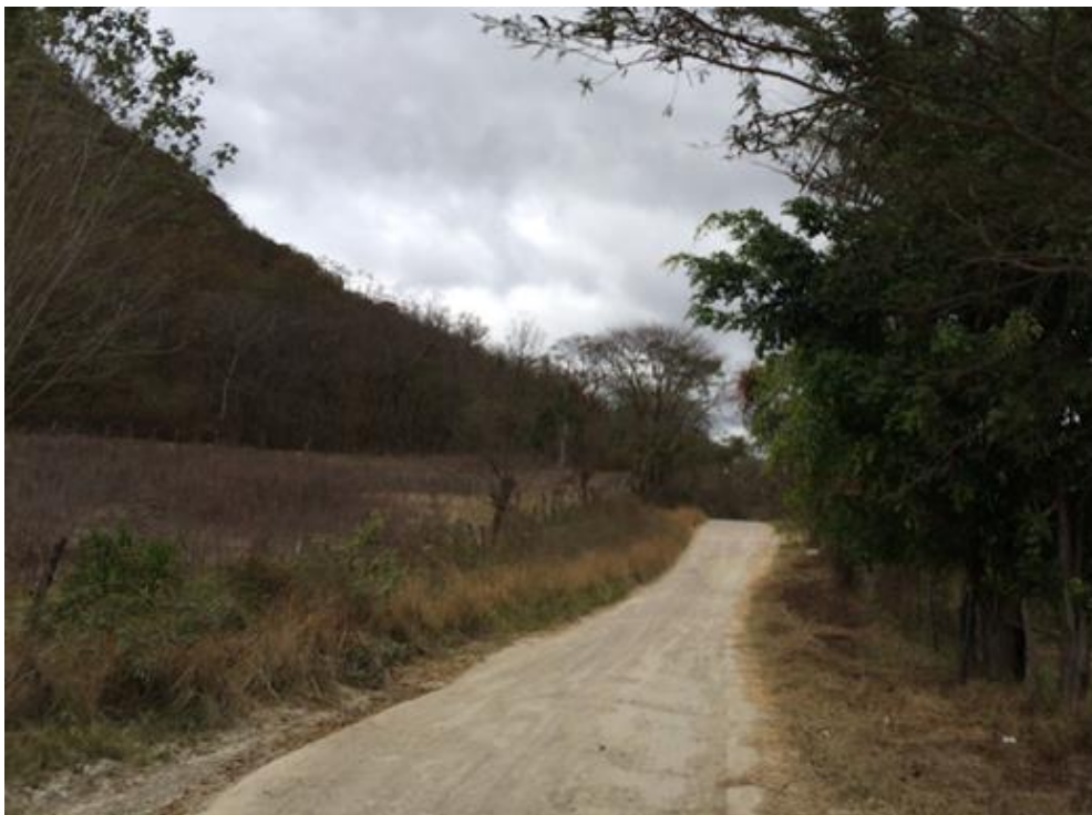
VISTA DEL FINAL DEL BALASTADO
