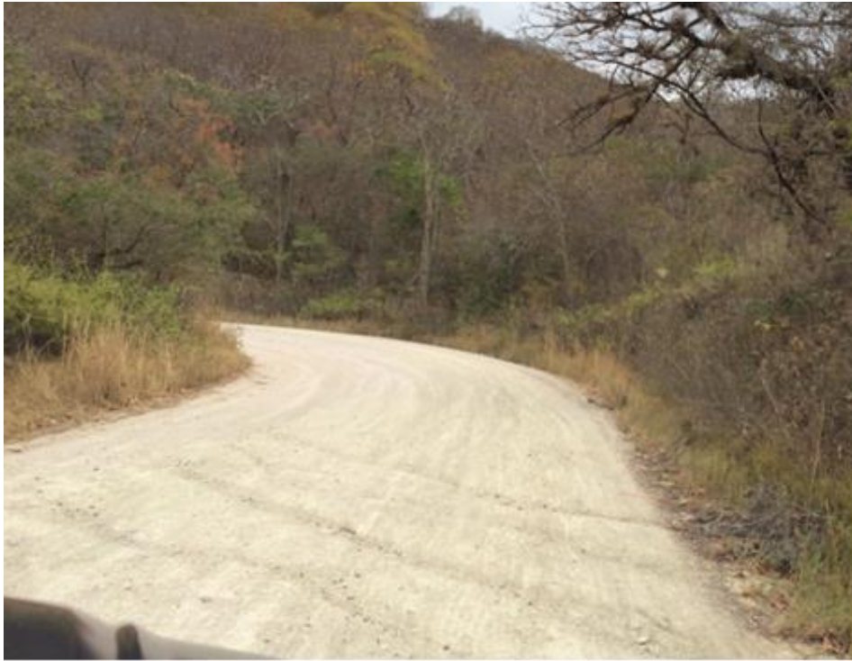
VISTA PANORÁMICA DE CALLE A REPARAR
