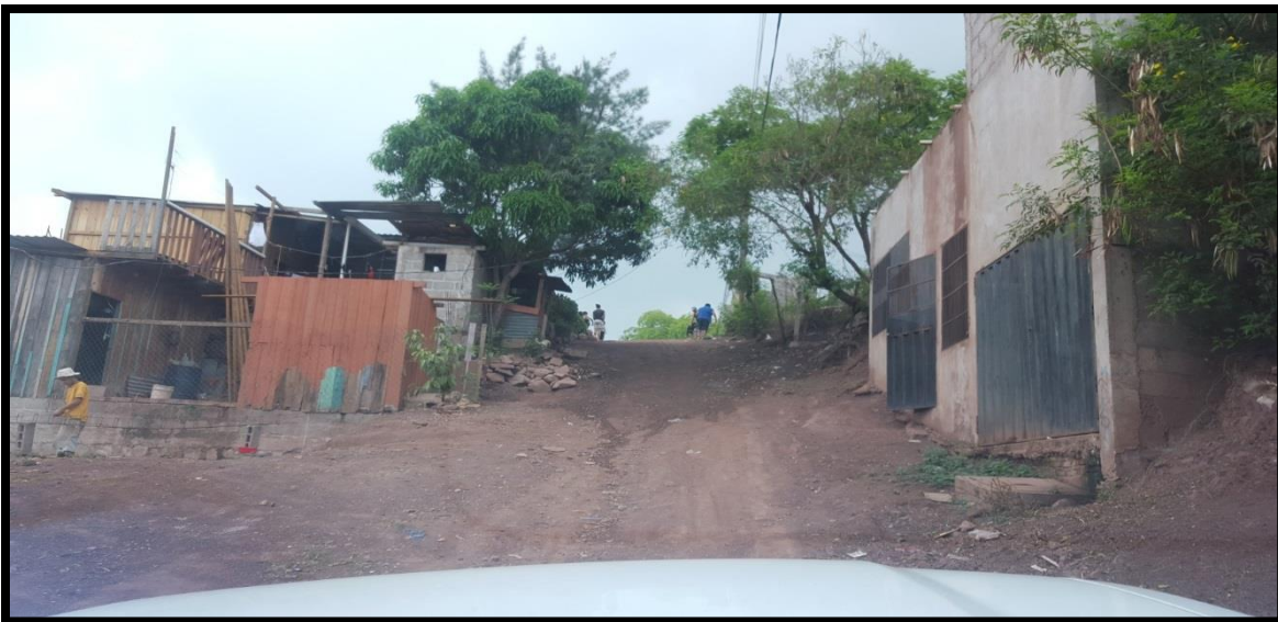
Vista panorámica del tramo a pavimentar
