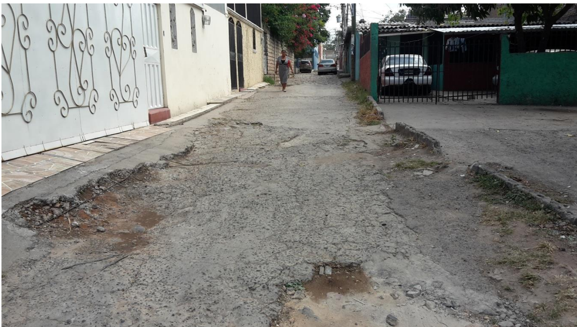
PANORÁMA DE CALLE A DEMOLER PARA PAVIMENTAR NUEVAMENTE
