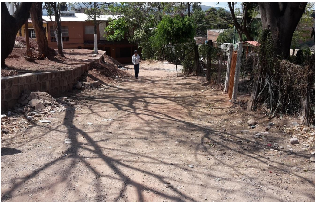
VISTA DE CALLE A PAVIMENTAR CON CONCRETO HIDRÁULICO
