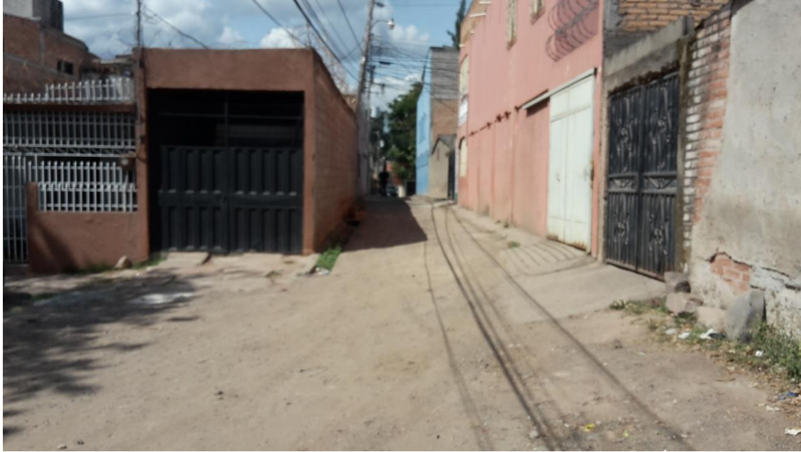
PANORÁMA DE LA CALLE A PAVIMENTAR
