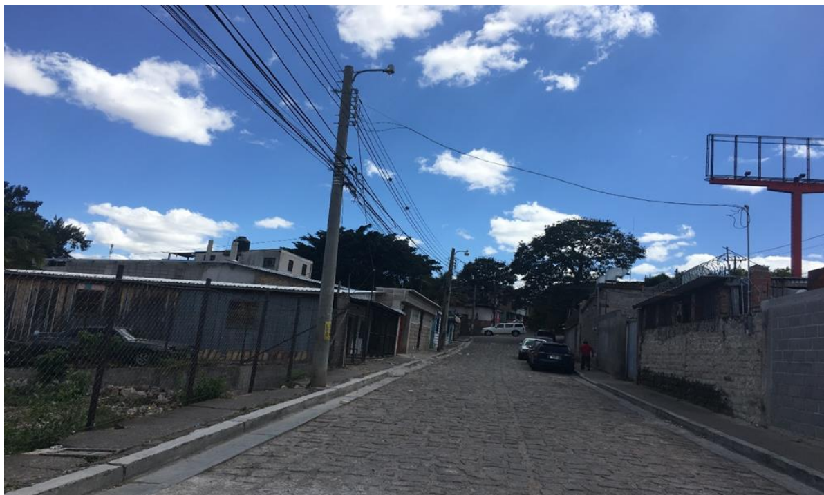
VISTA DE CALLE A PAVIMENTAR CON WHITE TOPPING
