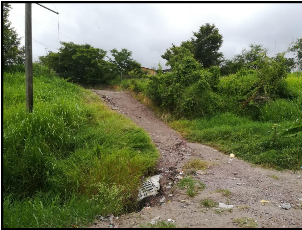
No.4 Ubicación del alcantarillado a sustituir, aquí desembocara cuneta No.1
