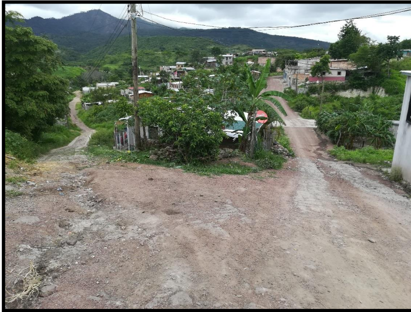
No.1 Vista inicial huellas vehiculares No. 2, también se construirán cunetas.
