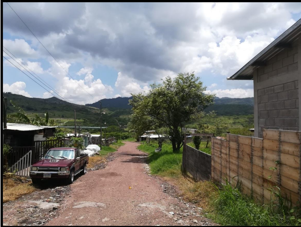
No.3 Vista de inicio de cuneta No.1, se construirá en lado derecho de la calle
