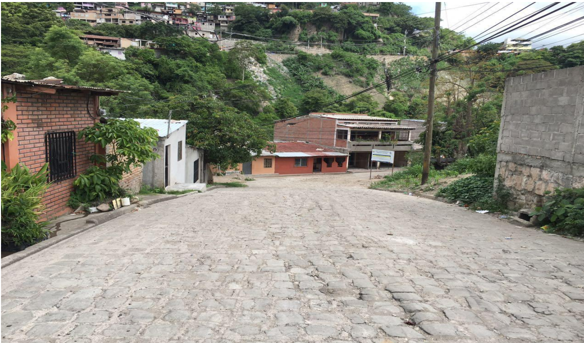
VISTA DEL FINAL DEL PROYECTO
