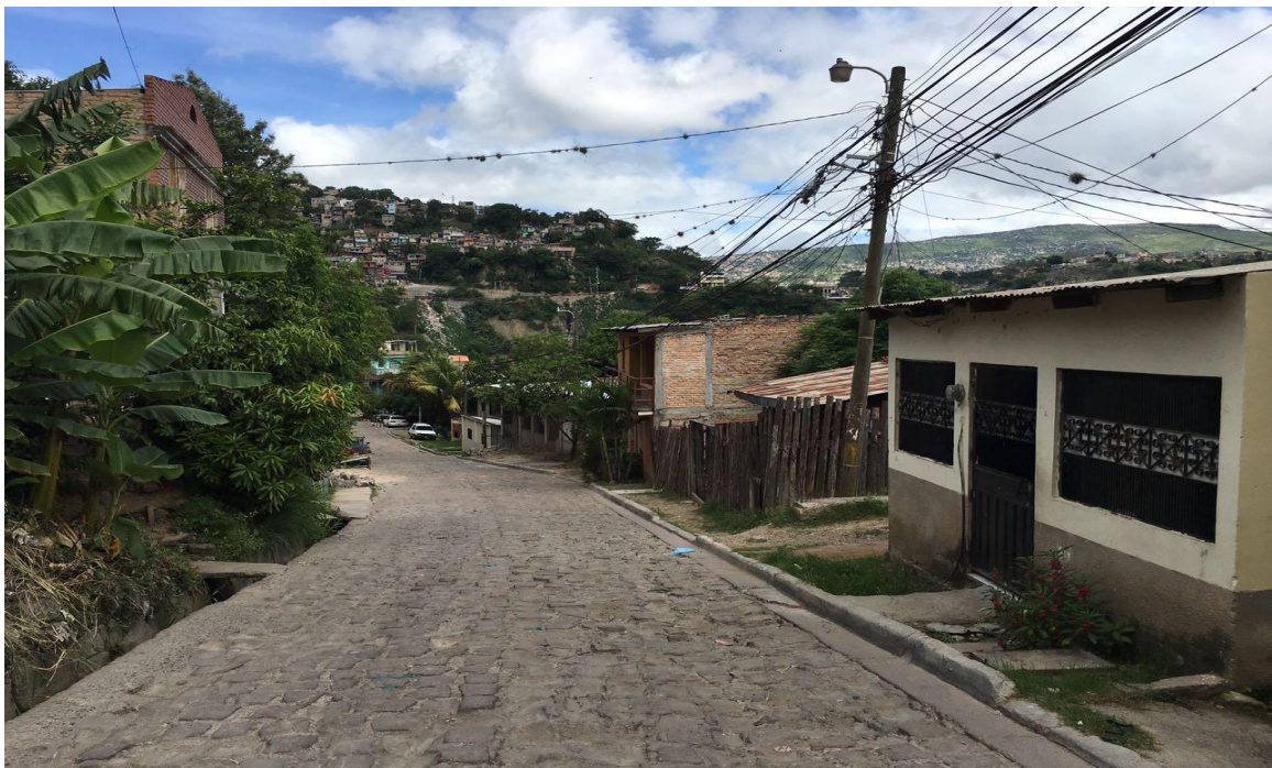
VISTA DE LA REPARACION DEL EMPEDRADO Y WHITE TOPPING
