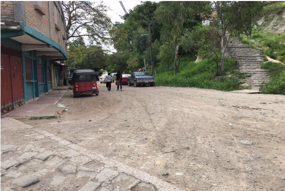
VISTA DEL TRAMO A PAVIMENTAR
