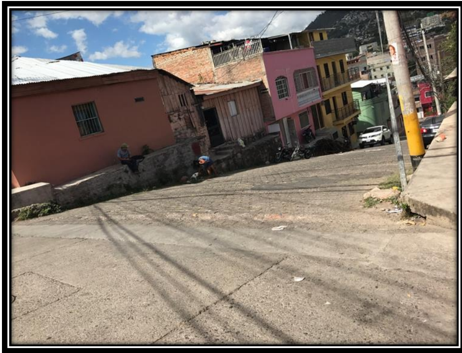
Foto No. 1: Inicio de calle a pavimentar
