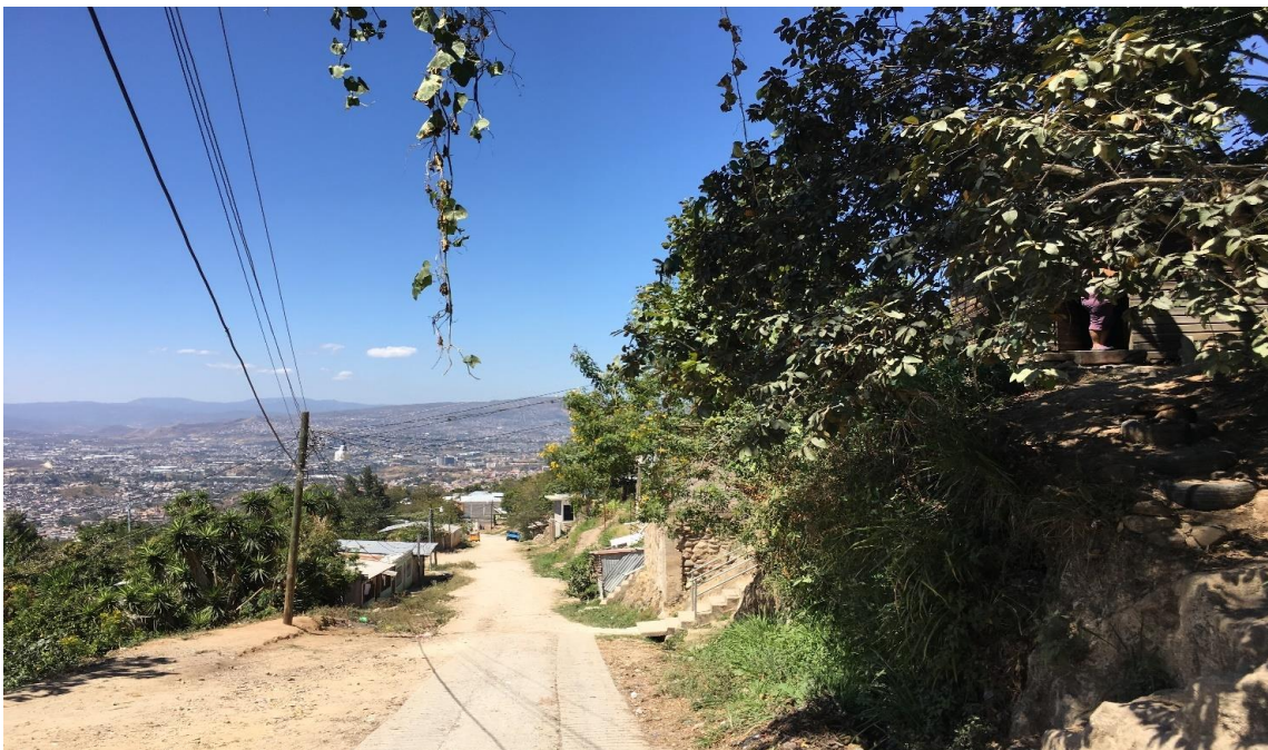
VISTA DONDE SE CONSTRUIRAN LAS HUELLAS VEHICULARES
