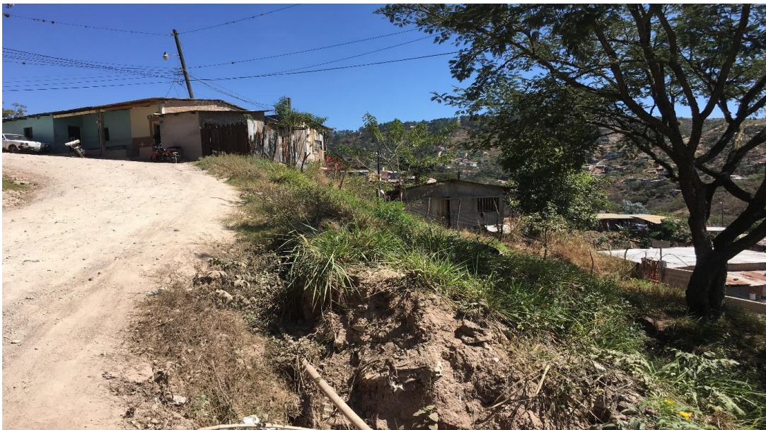
LUGAR DONDE SE CONSTRUIRA EL MURO DE CONTENCIÓN
